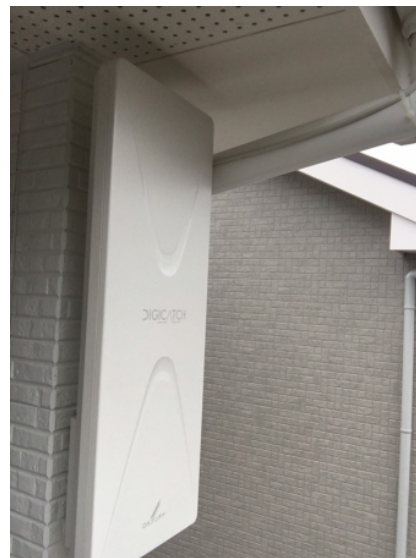
土浦市乙戸 壁面取付 デザインアンテナ工事
