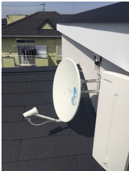
土浦市中 アイダ設計様物件 壁面取付 デザインアンテナとBSアンテナ工事
