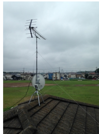
土浦市上高津新町 地デジアンテナとBSアンテナ屋根上工事
