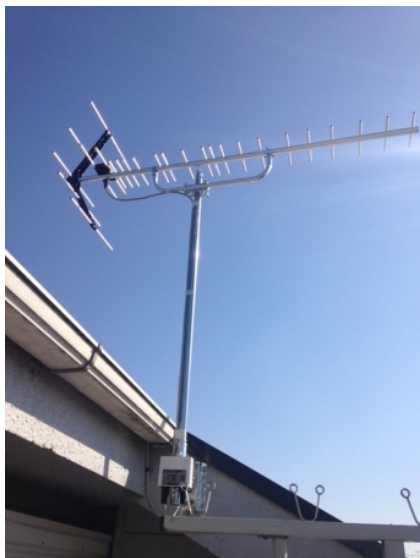
土浦市並木 壁面取付 地デジアンテナ工事
