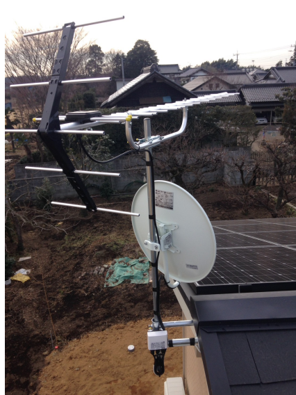
つくば市今鹿島 一条工務店様ご物件 破風板取付 八木式アンテナ・BSアンテナ工事
