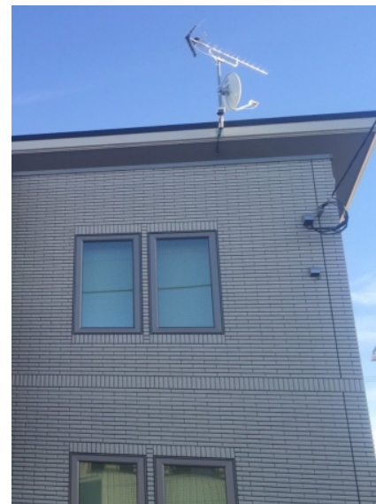
つくば市研究学園 一条工務店様物件 壁面取付 地デジアンテナとBSアンテナ工事
