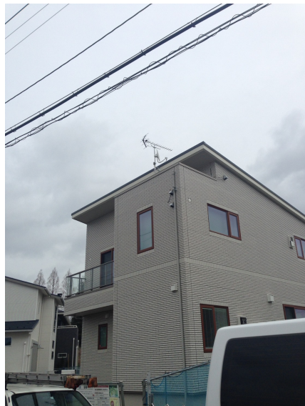
つくば市みどりの南 一条工務店様ご物件 破風板取付 八木式アンテナとBS/CSアンテナ
