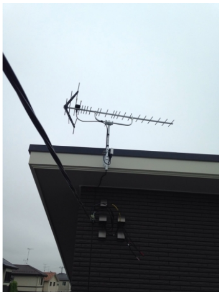
つくば市小白裕 一条工務店様物件 壁面取付 地デジアンテナ工事
