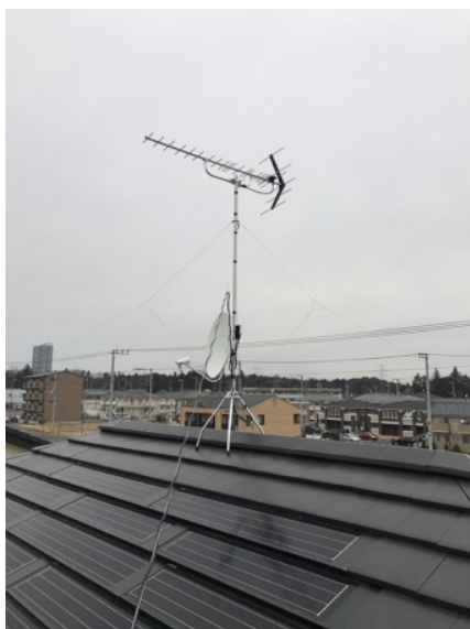
つくば市みどりの中央 大和ハウス様物件 地デジアンテナとBSアンテナ屋根上工事
