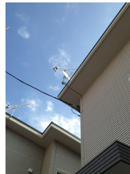
つくば市研究学園 一条工務店様物件 地デジアンテナとBSアンテナ工事後の外観
