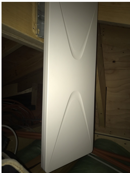
つくば市吾妻 エステーホーム様ご物件 屋根裏設置 デザインアンテナ工事
