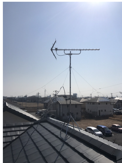
つくば市学園南 屋根上設置 八木式アンテナ工事 破風板取付 八木式アンテナとBS/CSアンテナ
