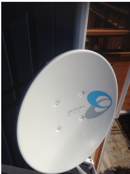
つくば市陣馬 スウェーデンハウス様物件 壁面取付 BSアンテナ工事
