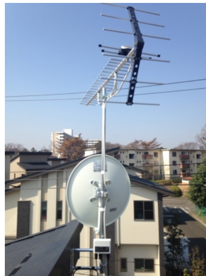
つくば市竹園 タカラレーベン様物件 壁面取付 地デジアンテナとBSアンテナ工事
