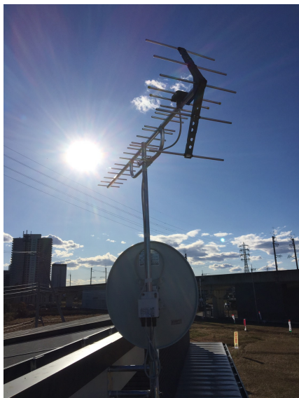
つくば市みどりの 壁面取付 八木式アンテナとBS/CSアンテナ工事
