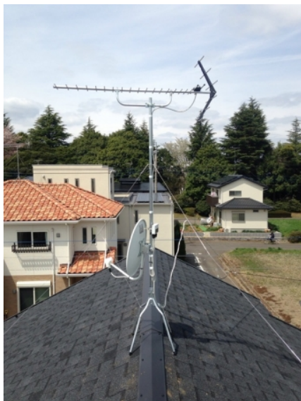
つくば市山中 地デジアンテナとBSアンテナ屋根上工事
