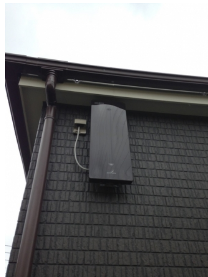
宇都宮市柳田町 壁面取付 デザインアンテナ工事
