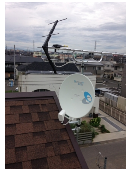
宇都宮市鶴田町 カクニシビルダー様物件 壁面取付 地デジアンテナとＢＳアンテナ工事
