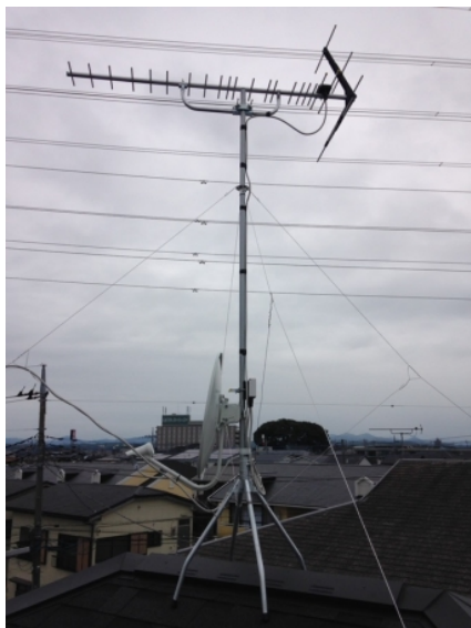
宇都宮市御幸本町 カクニシビルダー様物件 地デジアンテナとＢＳアンテナ屋根上工事
