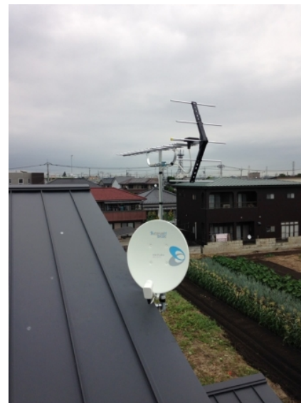
宇都宮市雀の宮 カクニシビルダー様物件 壁面取付 地デジアンテナとＢＳアンテナ工事
