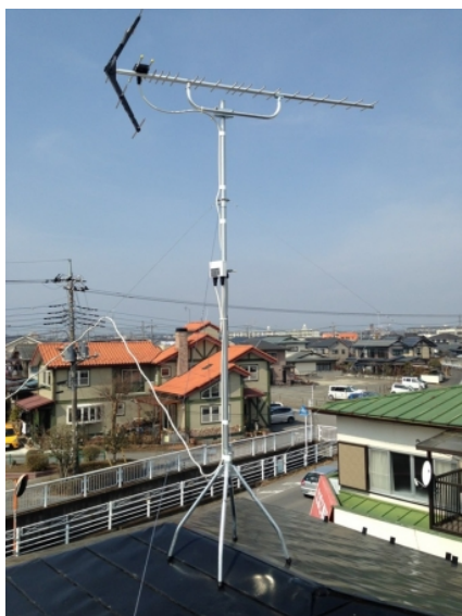
宇都宮市今宮 地デジアンテナ屋根上工事
