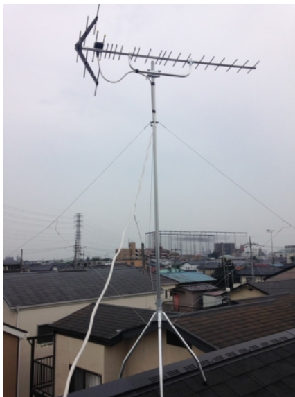
宇都宮市御幸町 アートハウス様物件 地デジアンテナ屋根上工事
