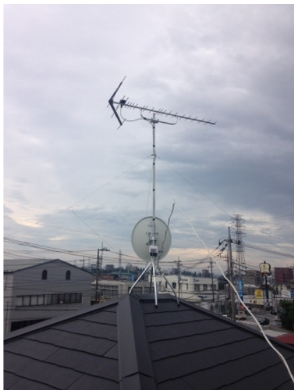
宇都宮市今泉町 カクニシビルダー様物件 地デジアンテナとBSアンテナ屋根上工事
