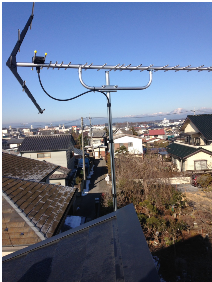
宇都宮市双葉 アートハウス様ご物件 破風板取付 八木式アンテナ工事
