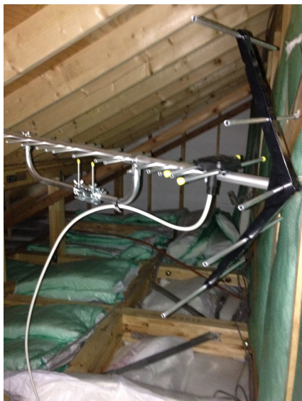
宇都宮市清原台 カクニシビルダー様物件 屋根裏設置 地デジアンテナ工事
