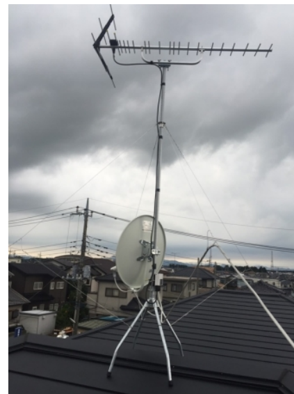
宇都宮市雀の宮 リンク様物件 地デジアンテナとBSアンテナ屋根上工事
