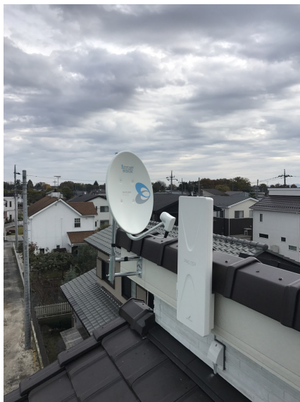
宇都宮市鑑山町 レオハウス様物件 デザインアンテナとBSアンテナ工事
