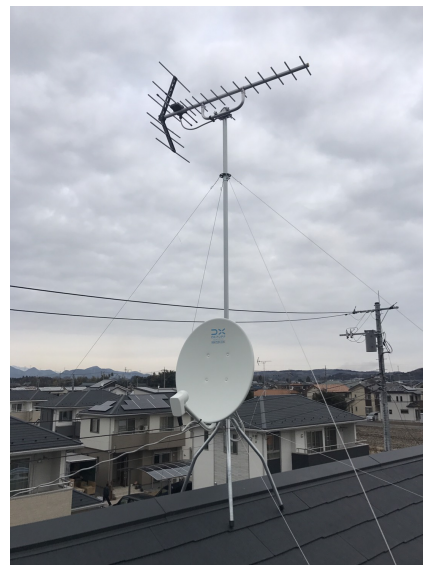
宇都宮市宝木本町 グランディハウス様ご物件 屋根上設置 八木式アンテナとBS/CSアンテナ工事
