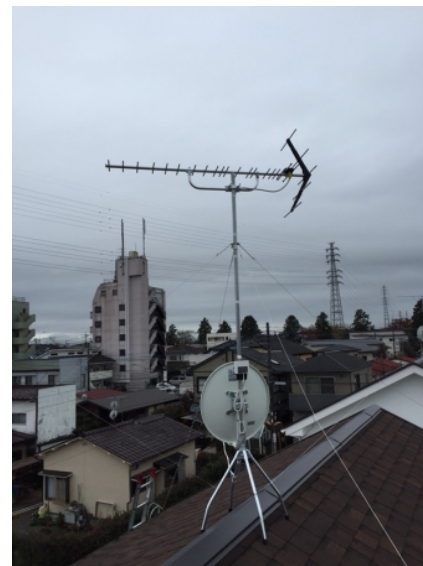
宇都宮市上戸祭町 ケイアイスター不動産様物件 地デジアンテナとBSアンテナ屋根上工事
