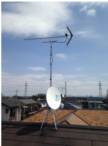
宇都宮市宮の内 アイダ設計様物件 地デジアンテナとBSアンテナ屋根上工事
