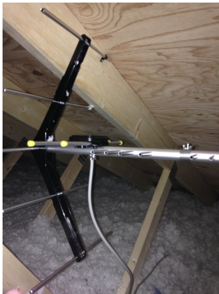
宇都宮市 スウェーデンハウス様ご物件 屋根裏設置 八木式アンテナ工事
