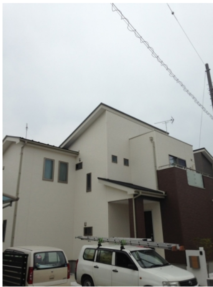
栃木市大平町 地デジアンテナ工事後の外観
