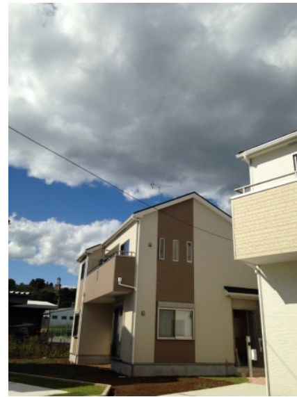
栃木市園部町 地デジアンテナ工事後の外観
