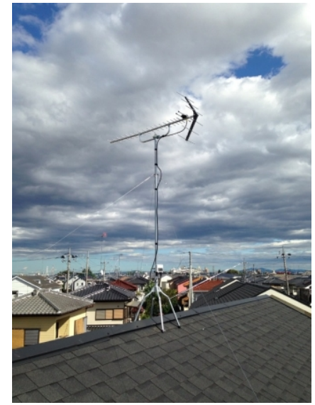
栃木市園部町 地デジアンテナ屋根上工事
