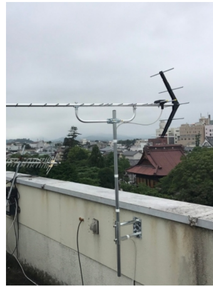
栃木市旭町 壁面取付 地デジアンテナ工事
