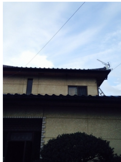
高崎市大八木町 地デジアンテナとBSアンテナ工事後の外観
