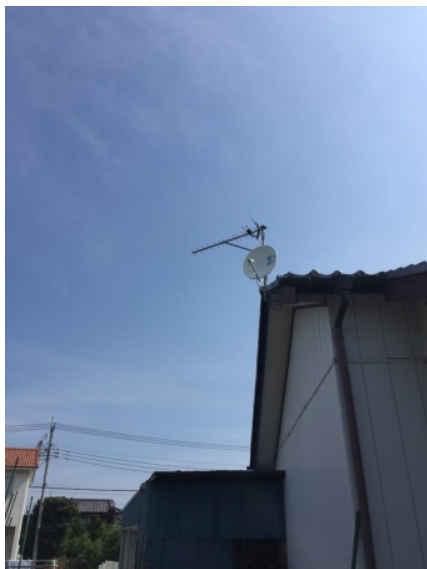
高崎市矢中町 BSアンテナ工事後の外観
