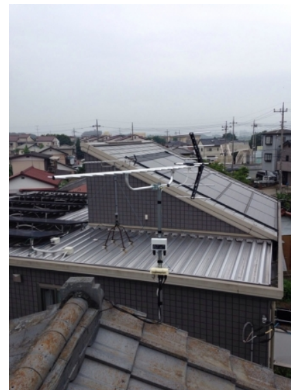
高崎市寺尾町 壁面取付 地デジアンテナ工事
