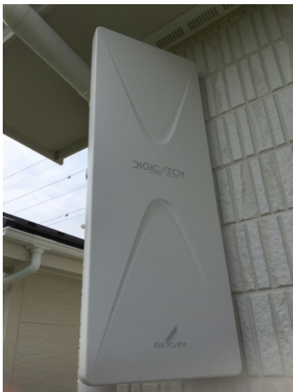
高崎市新町 一建設様物件 壁面取付 デザインアンテナ工事
