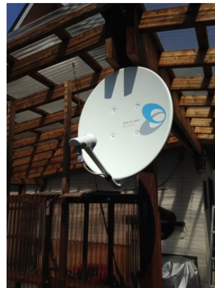
高崎市倉渕町 BSアンテナ工事
