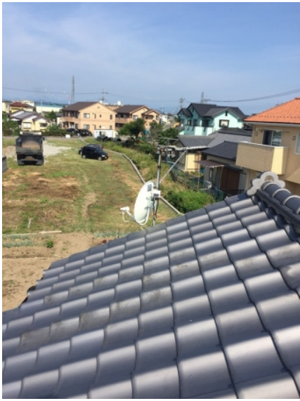
高崎市矢中町 BSアンテナ追加工事
