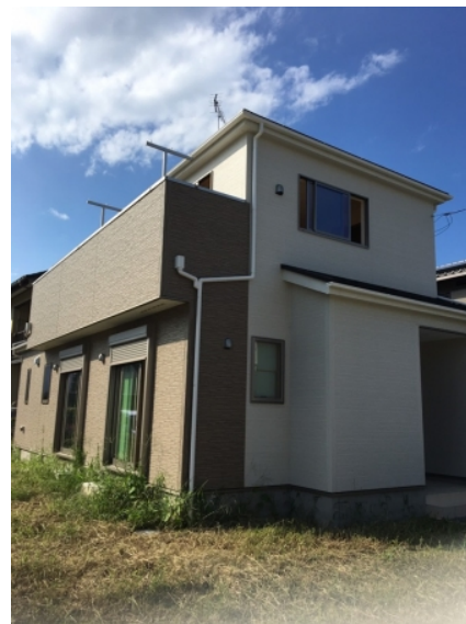
高崎市下豊岡町 地デジアンテナ工事後の外観
