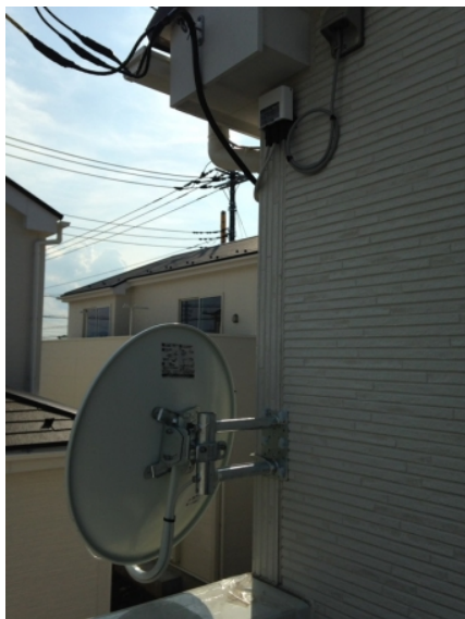
高崎市貝沢町 壁面取付 BSアンテナ工事
