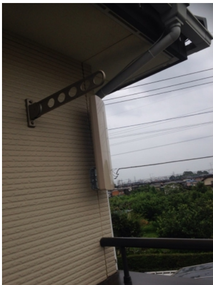
小山市乙女 壁面取付 デザインアンテナ工事
