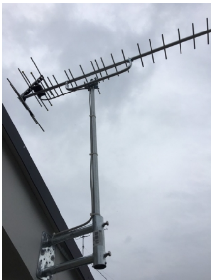
小山市中久喜 ケイアイスター不動産様物件 壁面取付 地デジアンテナ工事
