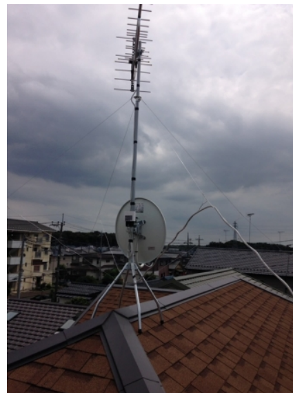
小山市扶桑 ケイアイスター不動産様物件 地デジアンテナとBSアンテナ屋根上工事
