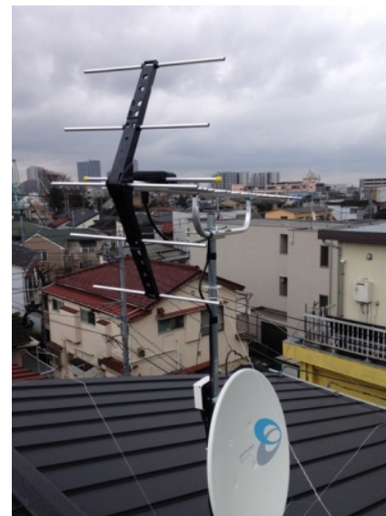
小山市横倉 ケイアイスター不動産様物件 地デジアンテナ屋根上工事
