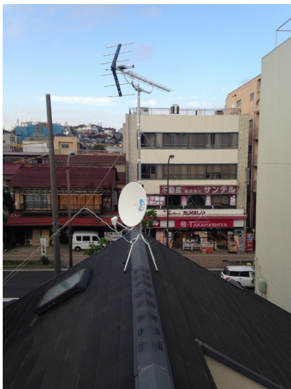
横浜市神奈川区三ツ沢下町 地デジアンテナとBSアンテナ屋根上工事
