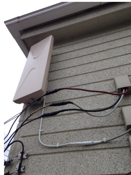
横浜市神奈川区菅田町 壁面取付 デザインアンテナ工事
