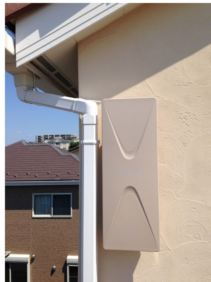
横浜市神奈川区栗田谷 壁面取付 デザインアンテナ工事
