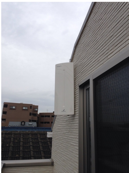
横浜市神奈川区神之木町 オープンハウス様物件 壁面取付 デザインアンテナ工事
