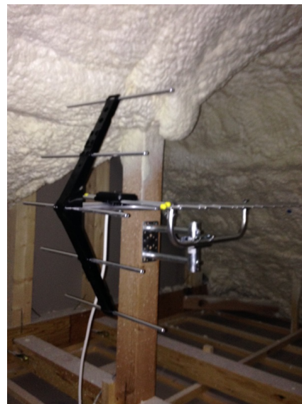
横浜市神奈川区西寺尾 地デジアンテナ屋根裏工事
