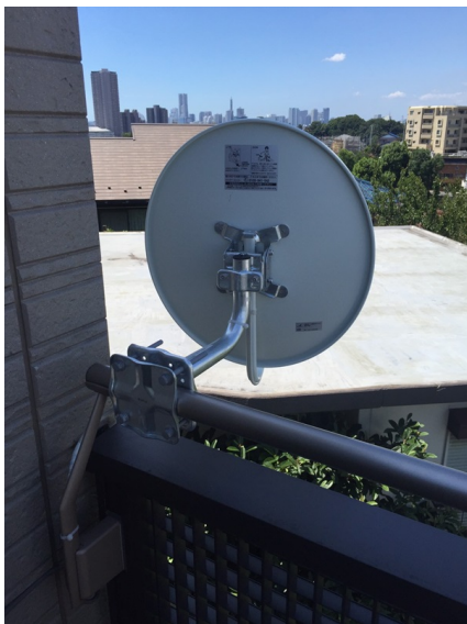
横浜市神奈川区西寺尾 バランダ取付 BSアンテナ工事
