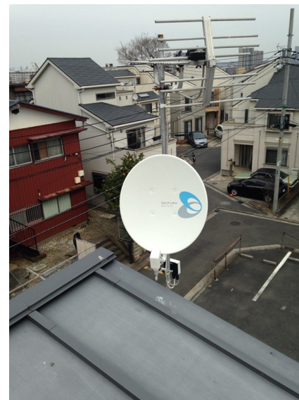
横浜市神奈川区高島台 壁面取付 地デジアンテナとBSアンテナ工事
