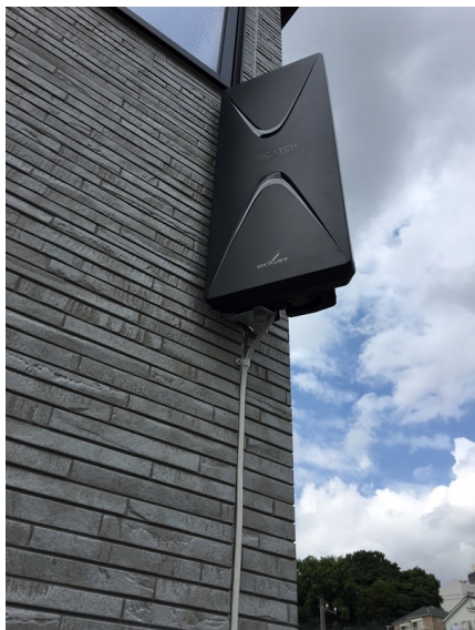
横浜市神奈川区白幡南町 壁面取付 デザインアンテナ工事
