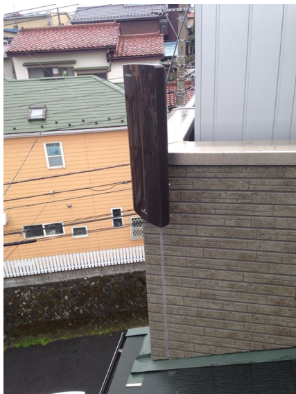
横浜市神奈川区神大寺 壁面取付 デザインアンテナ工事
