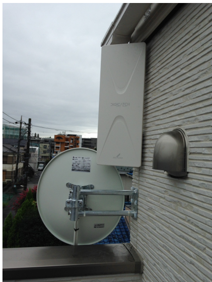
横浜市神奈川区片倉 リアルエーгент様物件 壁面取付 デザインアンテナとBSアンテナ工事
