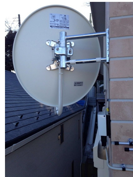
横浜市神奈川区白幡西町 壁面取付 BSアンテナ工事
