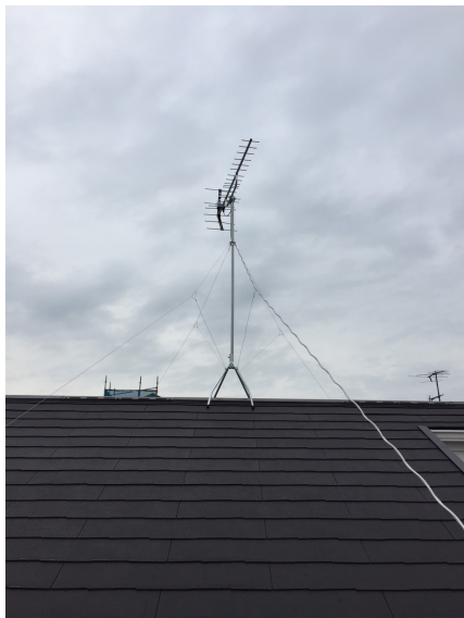
横浜市神奈川区白幡東町 屋根上設置 八木式アンテナ工事
