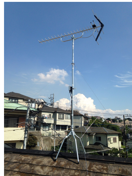
横浜市神奈川区西寺尾 地デジアンテナ屋根上工事
