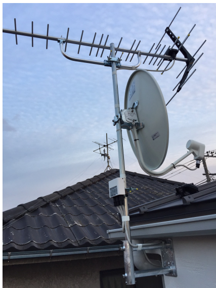
横浜市神奈川区三ツ沢上町 ecomo様物件 地デジアンテナとBSアンテナ工事
