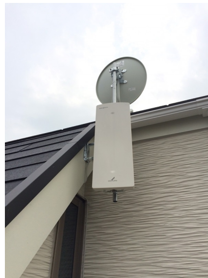
横浜市神奈川区神ノ木町 サンウエストホーム様物件 壁面取付 デザインアンテナとBSアンテナ工事
