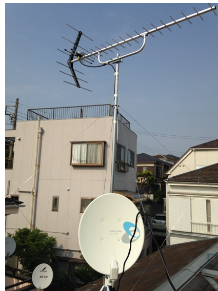
横浜市磯子区岡村 地デジアンテナとBSアンテナ屋根上工事
