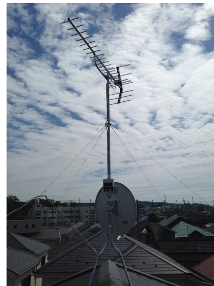
横浜市磯子区洋光台 地デジアンテナとBSアンテナ屋根上工事
