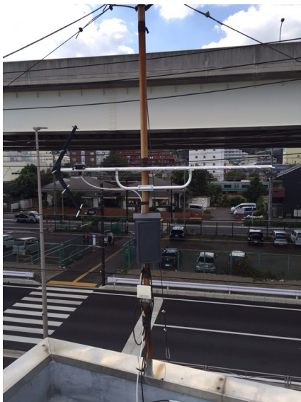
横浜市磯子区磯子 地デジアンテナ追加工事
