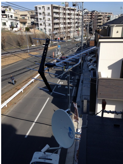
横浜市磯子区栗木 アサヒハウジング様物件 壁面取付 地デジアンテナとBSアンテナ工事
