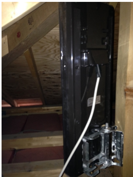
横浜市磯子区杉光台 細田工務店様物件 デザインアンテナ屋根裏工事
