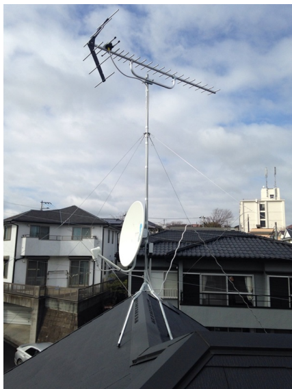
横浜市磯子区田中 地デジアンテナとBSアンテナ屋根上工事
