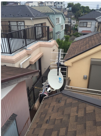
横浜市磯子区岡村 すまい様物件 壁面取付 地デジアンテナとBSアンテナ工事
