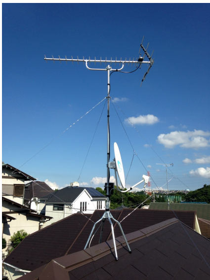
横浜市磯子区杉田 地デジアンテナとBSアンテナ屋根上工事
