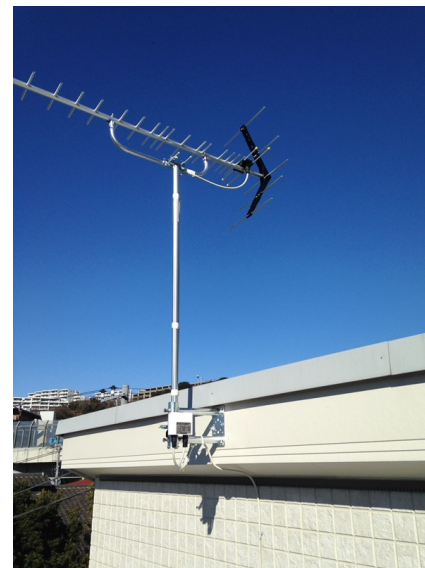
横浜市磯子区森 浜住研様物件 壁面取付 地デジアンテナ工事
