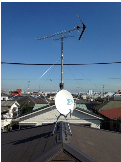
横浜市磯子区中原 地デジアンテナとBSアンテナ屋根上工事
