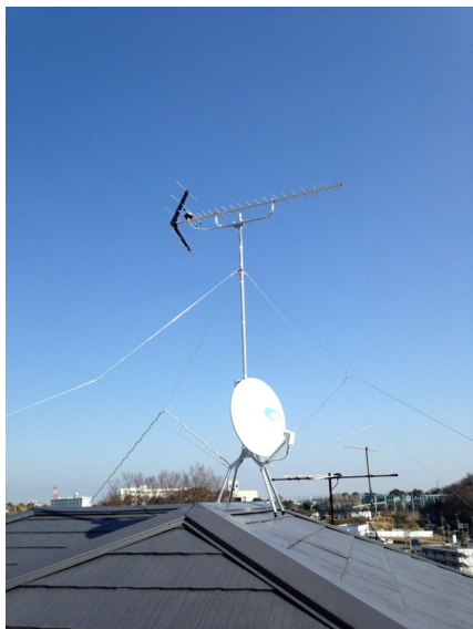
横浜市磯子区栗木 地デジアンテナとBSアンテナ屋根上工事
