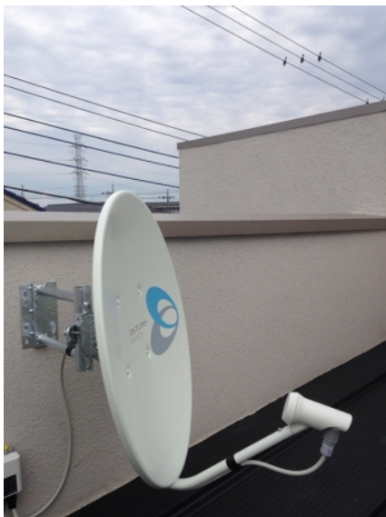
横浜市都筑区荏田南 イトーピアホーム様物件 壁面取付 BSアンテナ工事
