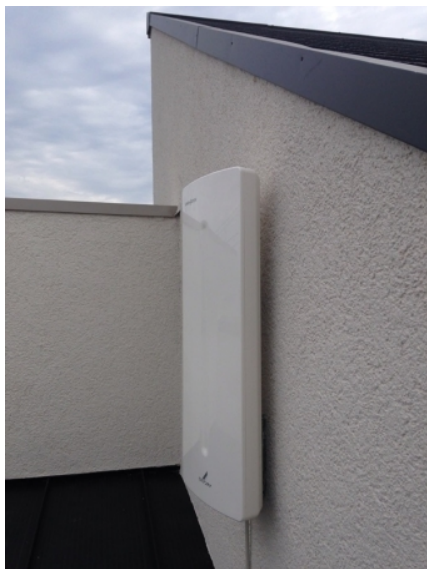
横浜市都筑区荏田南 イトーピアホーム様物件 壁面取付 デザインアンテナ工事
