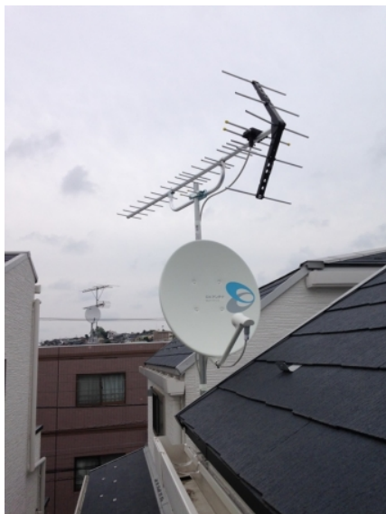
横浜市鶴見区東寺尾 オープンハウス様物件 壁面取付 地デジアンテナとBSアンテナ工事
