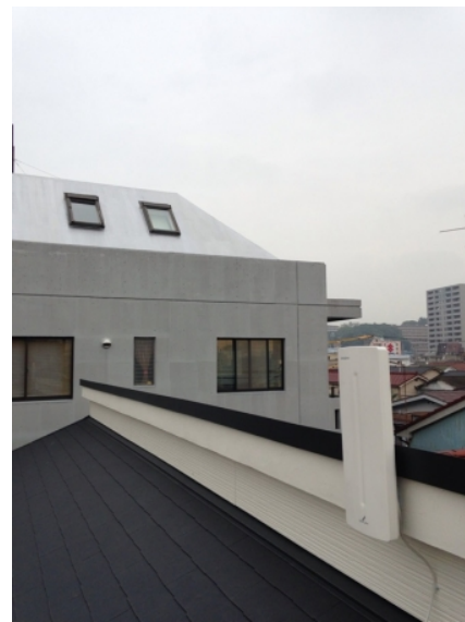
横浜市鶴見区生麦 壁面取付 デザインアンテナ工事
