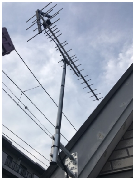
横浜市鶴見区馬場 壁面取付 地デジアンテナ工事
