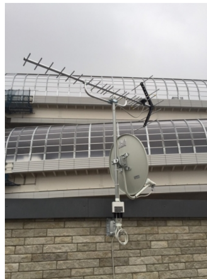
横浜市鶴見区生麦 壁面取付 地デジアンテナとBSアンテナ工事
