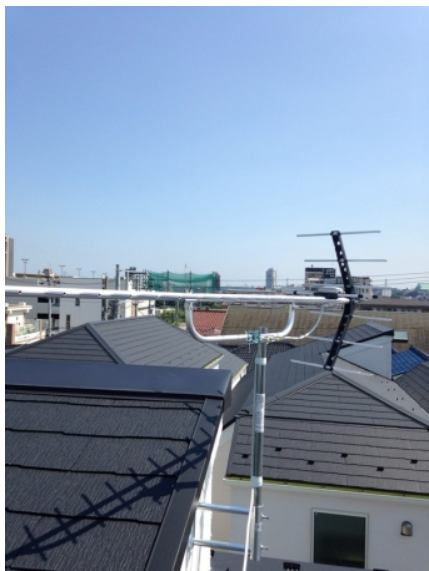
横浜市鶴見区下末吉 壁面取付 地デジアンテナ工事
