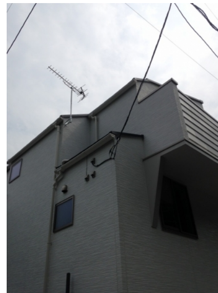
横浜市鶴見区岸谷 壁面取付 地デジアンテナ工事
