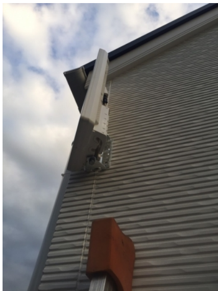
横浜市鶴見区岸谷 ひかり建設様物件 壁面取付 デザインアンテナ工事
