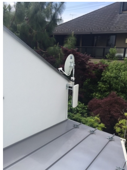
横浜市鶴見区岸谷 デックス様物件 壁面取付 デザインアンテナとBSアンテナ工事
