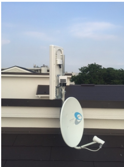
横浜市鶴見区東寺尾中台 フロンティア様物件 壁面取付 デザインアンテナとBSアンテナ工事
