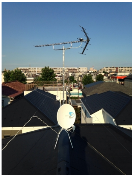
横浜市鶴見区菅沢町 地デジアンテナとBSアンテナ屋根上工事
