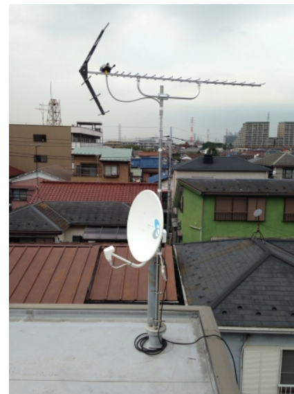
横浜市鶴見区下末吉 地デジアンテナとBSアンテナ工事
