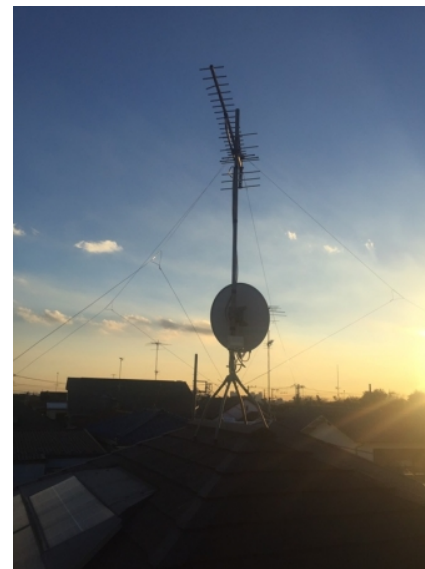
横浜市鶴見区馬場 パナホーム様物件 地デジアンテナとBSアンテナ屋根上工事
