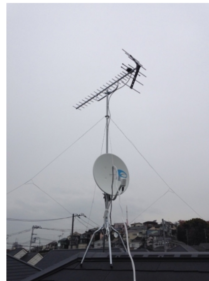
横浜市鶴見区駒岡 ひかり建設様物件 地デジアンテナとBSアンテナ屋根上工事
