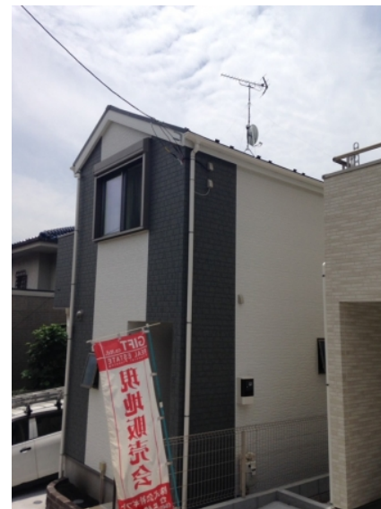
横浜市鶴見区上宮 三栄建築設計様物件 地デジアンテナとBSアンテナ工事後の外観
