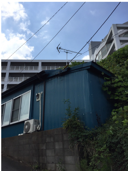
横浜市鶴見区下末吉 地デジアンテナ屋根上工事後の外観
