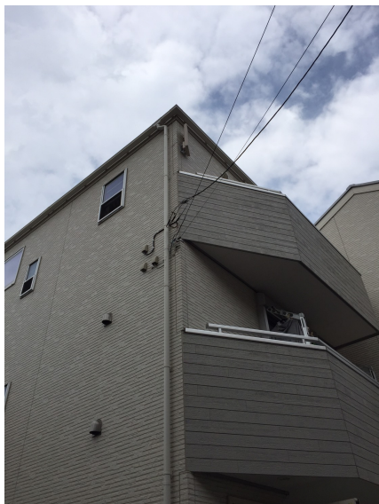
横浜市鶴見区朝日町 壁面取付 デザインアンテナ工事後の外観
