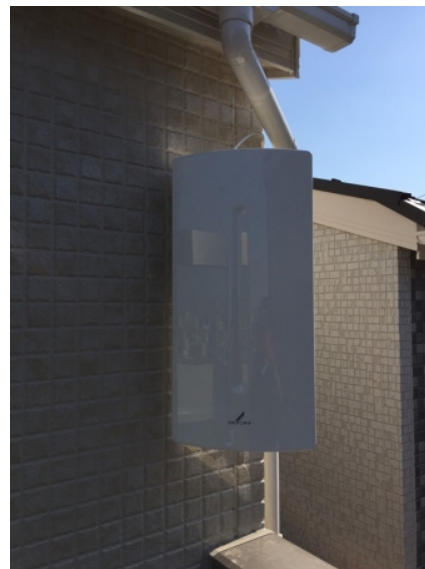
横浜市鶴見区下末吉 ひかり建設様物件 壁面取付 デザインアンテナ工事
