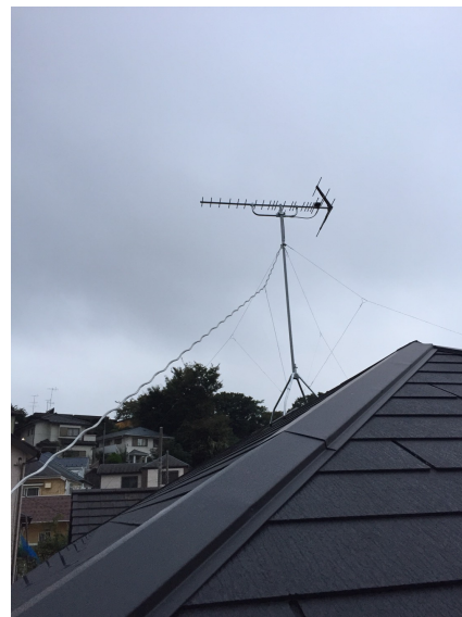
横浜市鶴見区東寺尾東台 タクトホーム様物件 地デジアンテナ屋根上工事
