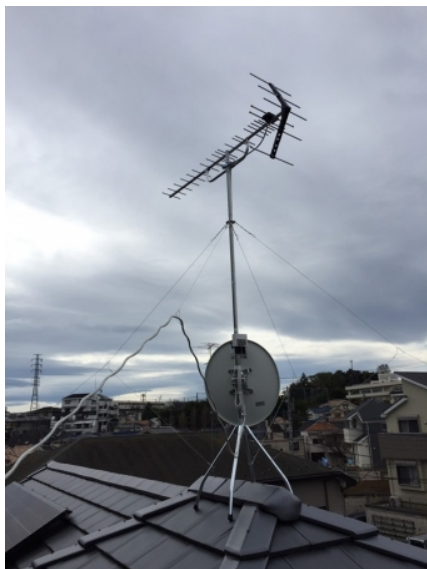
横浜市鶴見区上の宮 トヨタホーム様物件 地デジアンテナとBSアンテナ屋根上工事
