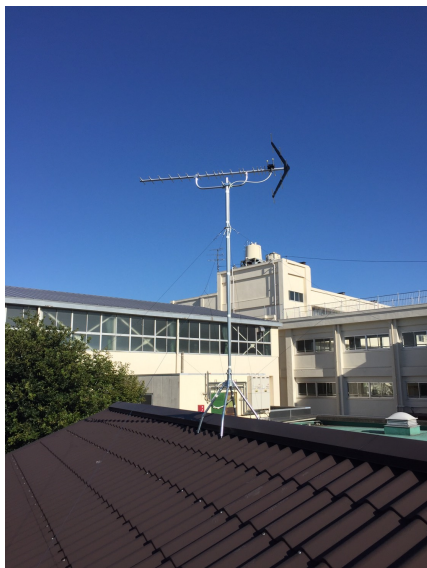
横浜市鶴見区獅子ヶ谷 地デジアンテナ屋根上工事
