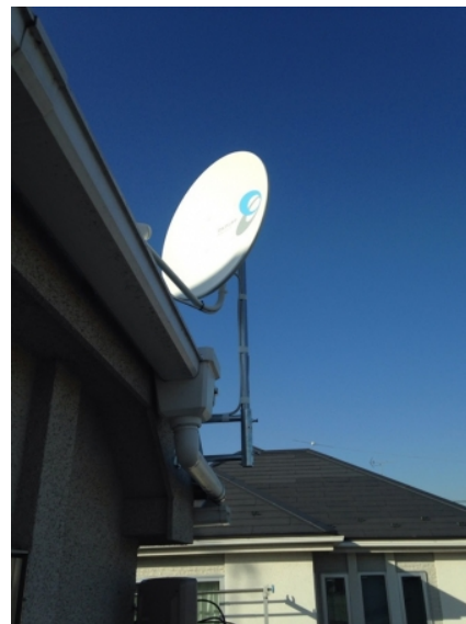
横浜市鶴見区北寺尾 幸和建設様物件 壁面取付 BSアンテナ工事
