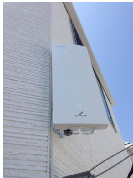
横浜市鶴見区東寺尾 オープンハウス様物件 壁面取付 デザインアンテナ工事
