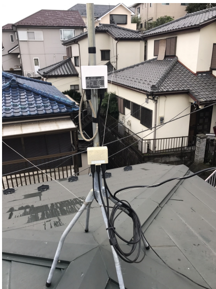
鶴見区馬場 ブースター交換工事
