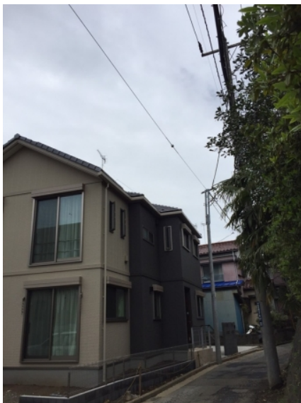
横浜市鶴見区上の宮 トヨタホーム様物件 地デジアンテナとBSアンテナ工事後の外観
