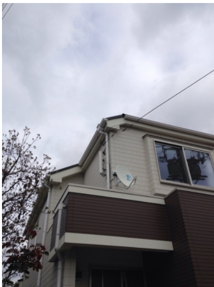
横浜市鶴見区北寺尾 飯田産業様物件 デザインアンテナとBSアンテナ工事後の外観
