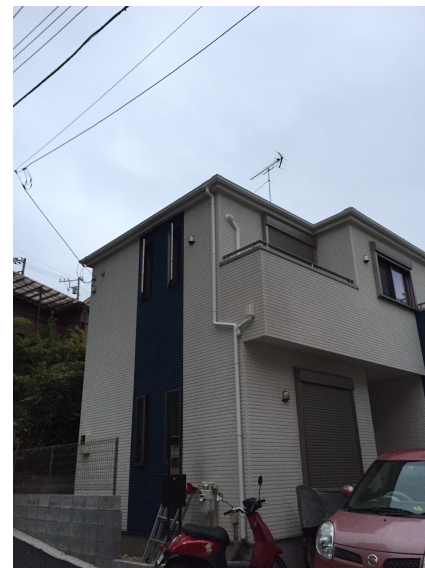
横浜市鶴見区東寺尾東台 タクトホーム様物件 地デジアンテナ屋根上工事後の外観
