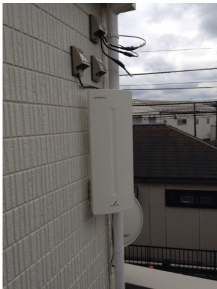
横浜市鶴見区北寺尾 飯田産業様物件 壁面取付 デザインアンテナとBSアンテナ工事
