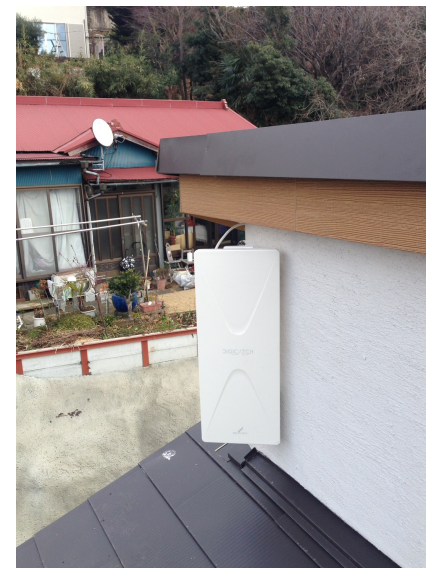
戸塚区平戸町 カキザワ工務店様ご物件 壁面取付 デザインアンテナ工事
