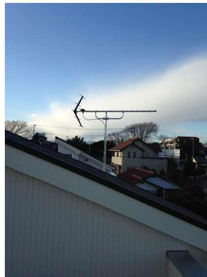
戸塚区原宿 八木式アンテナ工事
