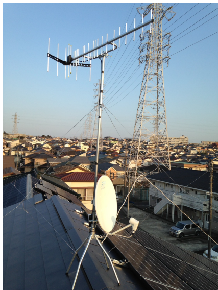
横浜市戸塚区汲沢 カキザワ工務店様ご物件 屋根上設置 八木式アンテナとBS/CSアンテナ
