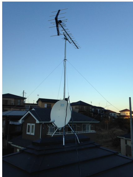
横浜市戸塚区小雀町 屋根上設置 八木式アンテナとBS/CSアンテナ工 事
