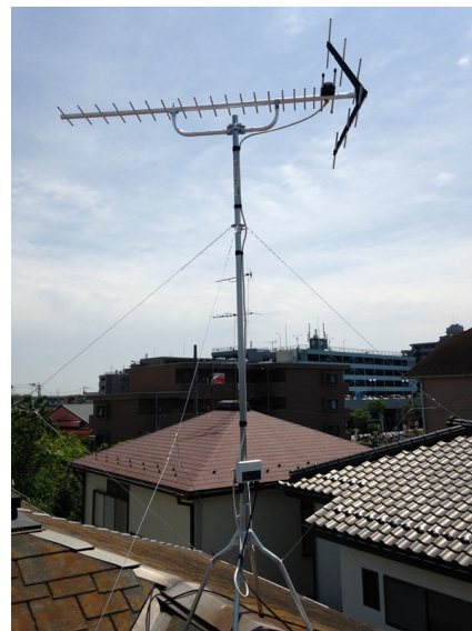
横浜市瀬谷区中央 地デジアンテナ屋根上工事
