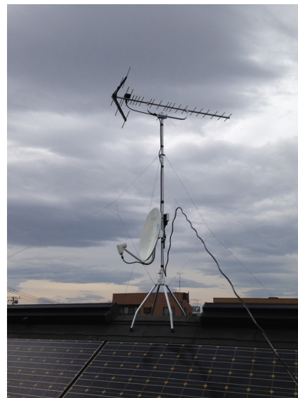
横浜市瀬谷区橋戸 地デジアンテナとBSアンテナ屋根上工事
