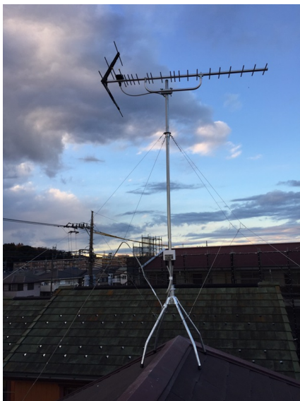
横浜市瀬谷区北新 地デジアンテナ屋根上工事
