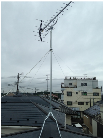
横浜市瀬谷区三ツ境 地デジアンテナ屋根上工事
