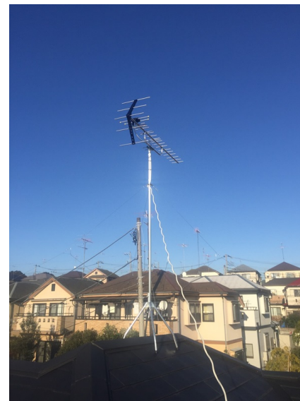
横浜市瀬谷区二ツ橋町 地デジアンテナ屋根上工事
