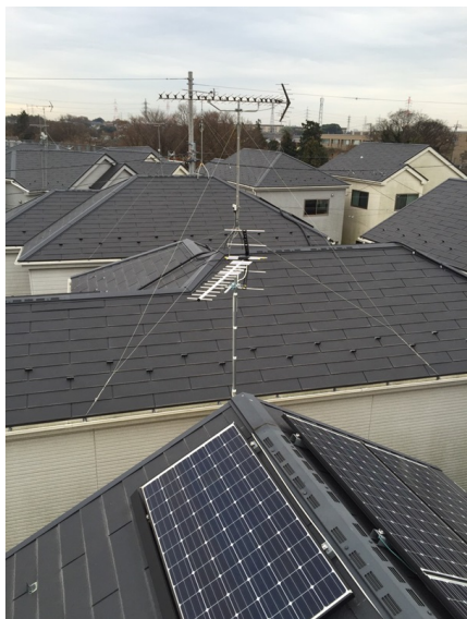
横浜市瀬谷区阿久和南 壁面取付 地デジアンテナ工事
