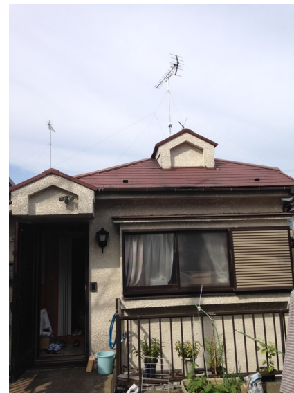
横浜市瀬谷区阿久和西 地デジアンテナ工事後の外観
