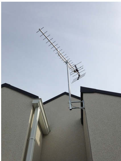
横浜市瀬谷区瀬谷町 壁面取付 地デジアンテナ工事
