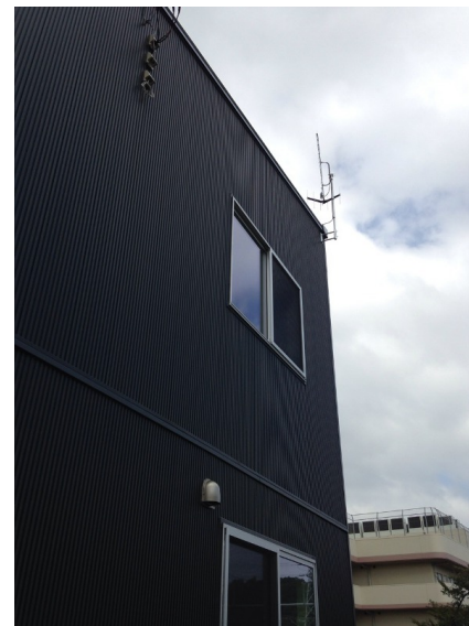
横浜市瀬谷区阿久和南 地デジアンテナ工事後の外観
