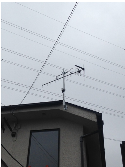
横浜市瀬谷区阿久和東 地デジアンテナ工事後の外観
