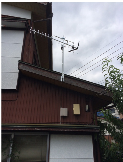
横浜市瀬谷区竹村町 垂直偏波受信 壁面取付 地デジアンテナ工事
