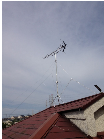
横浜市瀬谷区阿久和西 地デジアンテナ屋根上工事
