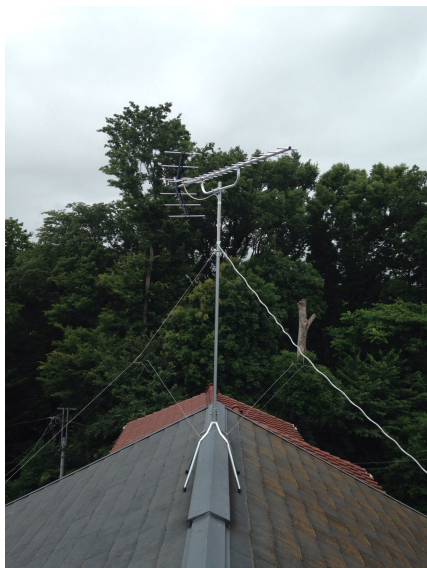
横浜市瀬谷区中屋敷 地デジアンテナ屋根上工事
