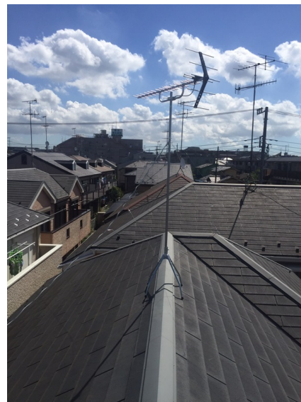
横浜市瀬谷区瀬谷 地デジアンテナ屋根上工事
