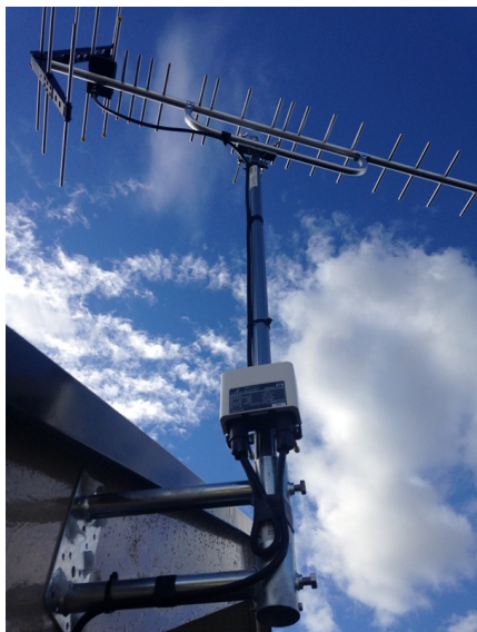
横浜市瀬谷区阿久和東 壁面取付 地デジアンテナ工事
