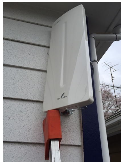
横浜市南区永田北 壁面取付 デザインアンテナ工事
