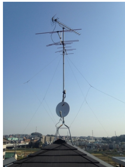
横浜市緑区十日市場町 地デジアンテナとBSアンテナ屋根上工事
