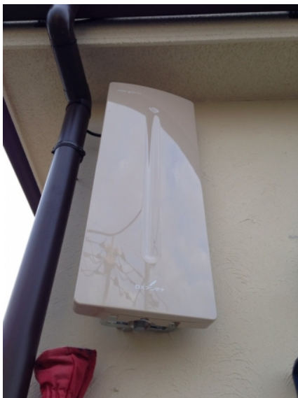
横浜市緑区中山町 ホークワン様物件 壁面取付 デザインアンテナ工事
