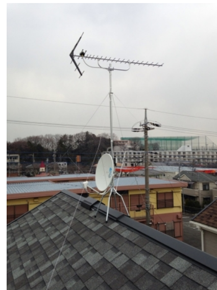
横浜市緑区霧が丘 地デジアンテナとBSアンテナ屋根上工事
