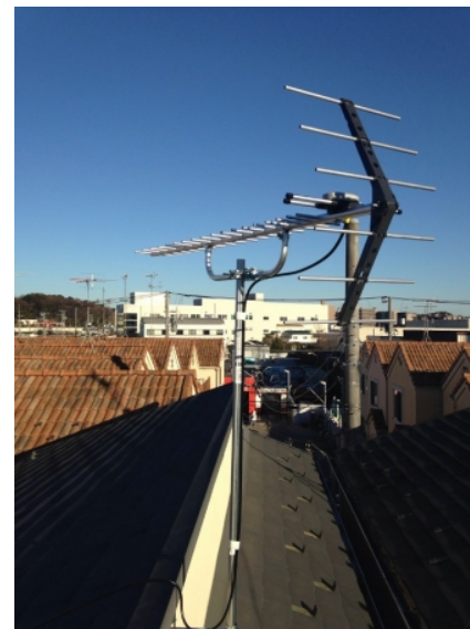
横浜市緑区上山 壁面取付 地デジアンテナ工事
