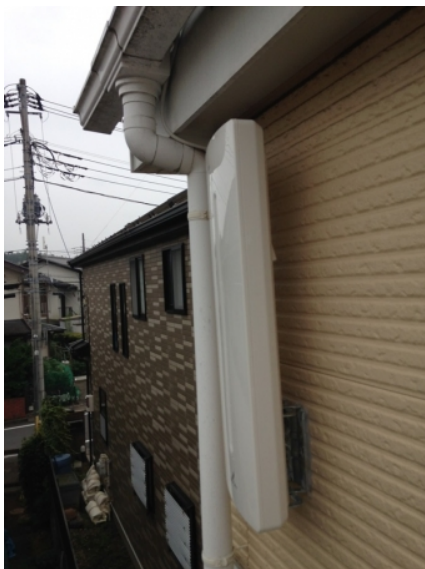
横浜市緑区霧が丘 壁面取付 デザインアンテナ工事
