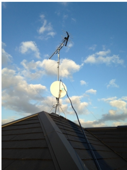
横浜市緑区台村 津久見建設様物件 地デジアンテナとBSアンテナ屋根上工事
