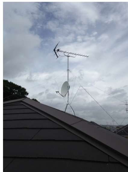
横浜市緑区中山町 アサヒハウジング様物件 地デジアンテナとBSアンテナ屋根上工事
