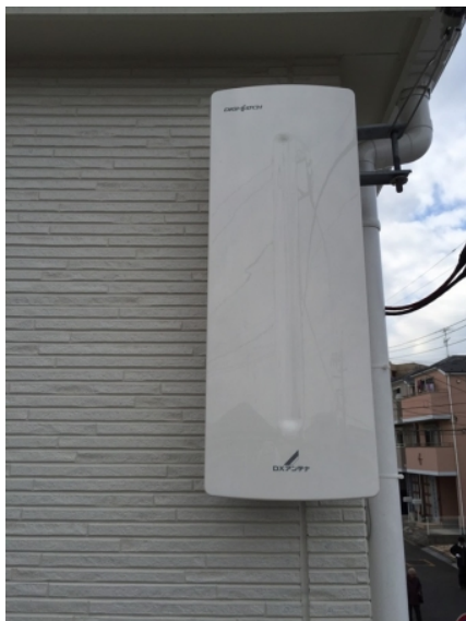
横浜市緑区霧が丘 オリエンタルホーム様物件 壁面取付 デザインアンテナ工事
