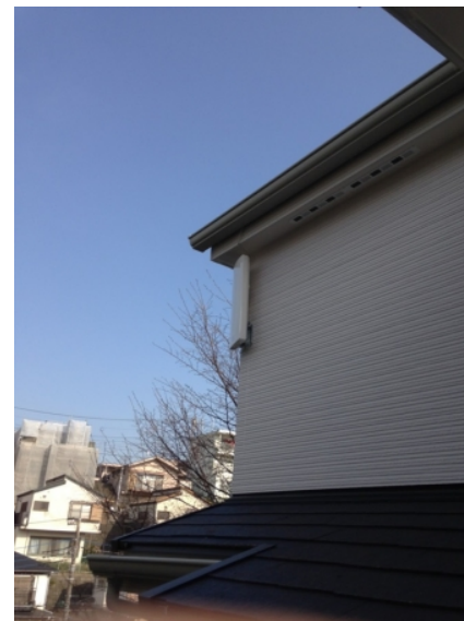
横浜市緑区中山町 浜住研様物件 壁面取付 デザインアンテナ工事
