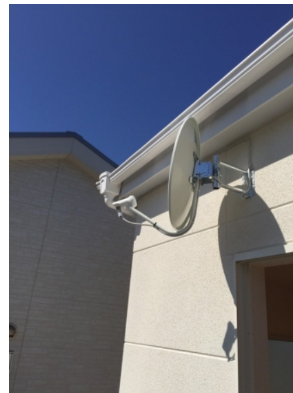
横浜市緑区北八朔町 壁面取付 B S アンテナ工事
