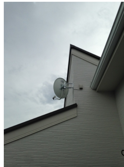
横浜市緑区寺山町 プロネット様物件 壁面取付 BSアンテナ工事
