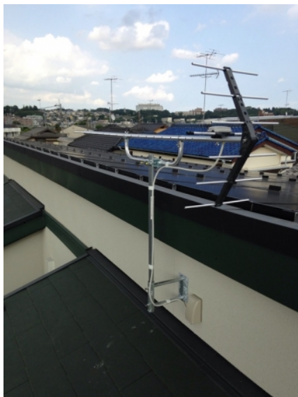
横浜市緑区北八朔町 一条工務店様物件 壁面取付 地デジアンテナ工事
