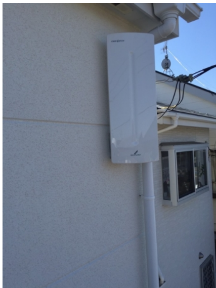
横浜市緑区北八朔町 壁面取付 デザインアンテナ工事
