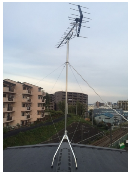
横浜市緑区中山町 ひかり建設様物件 地デジアンテナ屋根上工事
