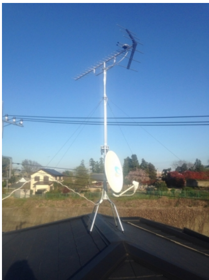
横浜市緑区長津田 ひかり建設様物件 地デジアンテナとBSアンテナ屋根上工事
