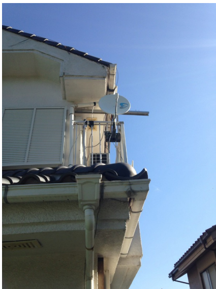
横浜市港南区丸山台 BSアンテナ工事後の外観
