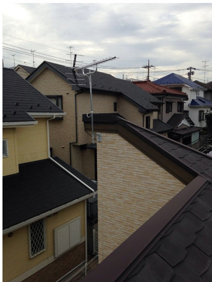
横浜市港南区下永谷 壁面取付 地デジアンテナ 工事
