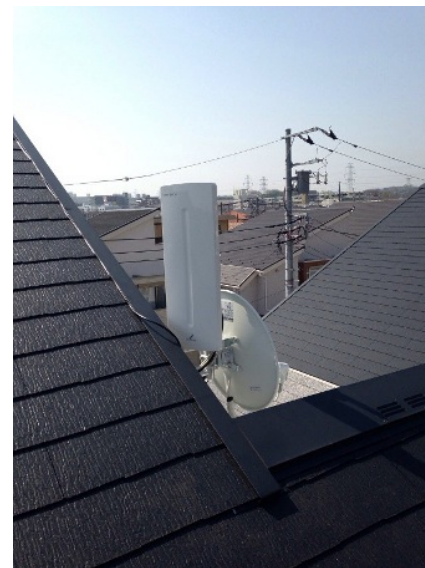
横浜市港南区上永谷 壁面取付 デザインアンテナとBSアンテナ工事
