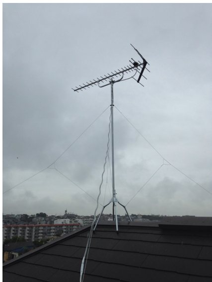
横浜市港南区荻が谷 地デジアンテナ屋根上工事
