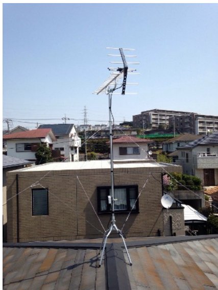
横浜市港南区日野南 地デジアンテナ屋根上工事
