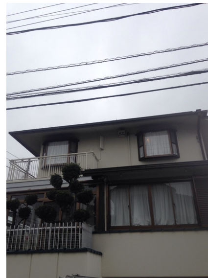
横浜市港南区港南台 壁面取付 地デジアンテナ 工事
