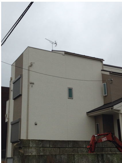
横浜市港南区東永谷 アンテナ工事後の外観
