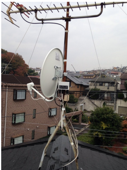
横浜市港南区日野 BSアンテナ追加工事
