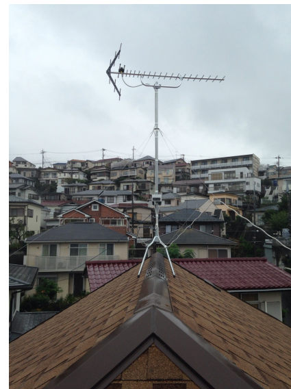
横浜市港南区日野 地デジアンテナ屋根上工事
