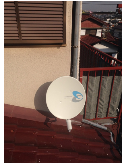
横浜市港南区日野 壁面取付 BSアンテナ工事
