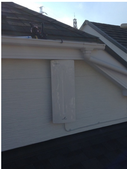
横浜市港南区港南台 壁面取付 デザインアンテナ工事
