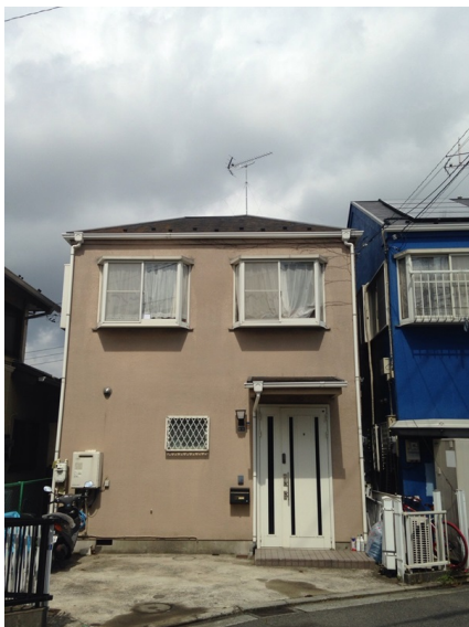
横浜市港南区荻が谷 地デジアンテナ工事後の外観
