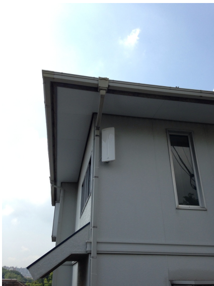
横浜市港南区日野 デザインアンテナ工事後の外観
