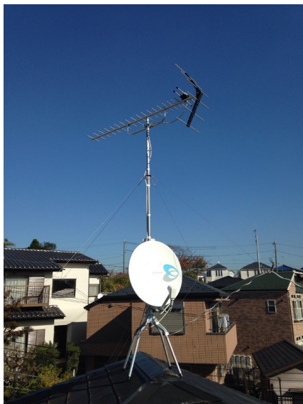
横浜市港南区日野 地デジアンテナとBSアンテナ屋根上工事
