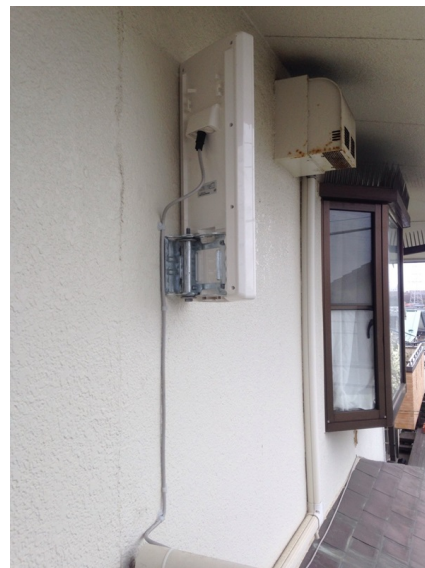
横浜市港南区日野南 壁面取付 デザインアンテナ工事
