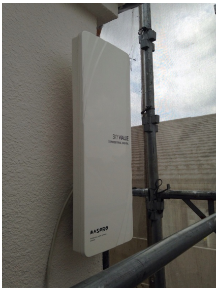
横浜市港南区大久保 壁面取付 デザインアンテナ工事
