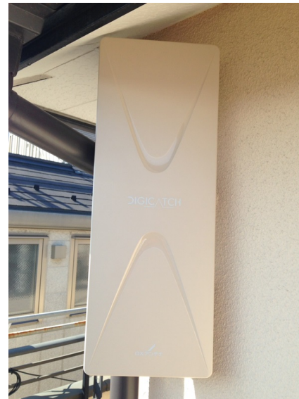
横浜市港南区永谷 壁面取付 デザインアンテナ 工事
