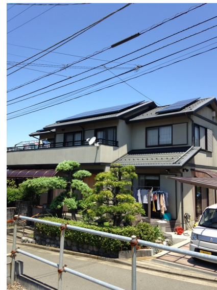
横浜市港南区港南 CSアンテナ工事後の外観
