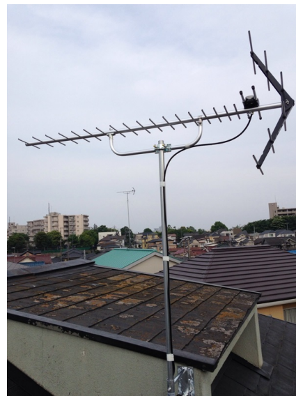
横浜市港南区荻が谷 壁面取付 地デジアンテナ工事
