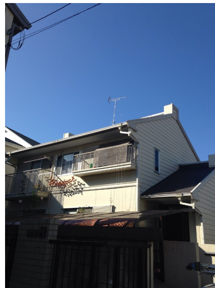
横浜市港南区東永谷 地デジアンテナ工事後の外 観
