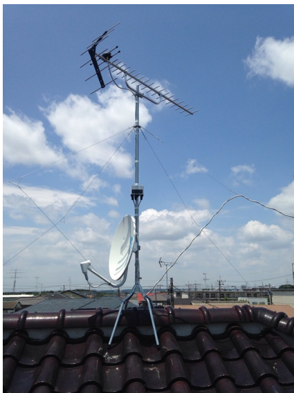
横浜市港南区日限山 地デジアンテナとBSアンテナ屋根上工事
