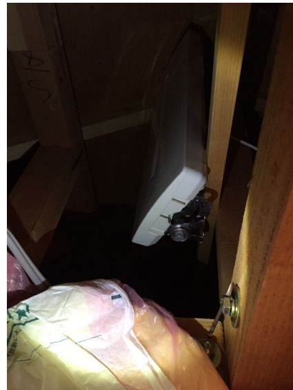
横浜市港南区港南 デザインアンテナ屋根裏工事
