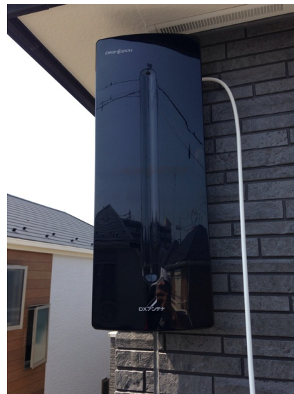
横浜市港南区日野 壁面取付 デザインアンテナ工事
