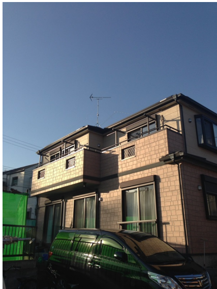
横浜市港南区日野 地デジアンテナ工事後の外観
