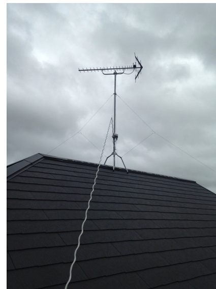
横浜市港南区荻が谷 デザインアンテナ工事後の外観
