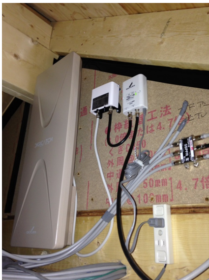
横浜市港北区篠原西町 デザインアンテナ屋根裏 工事
