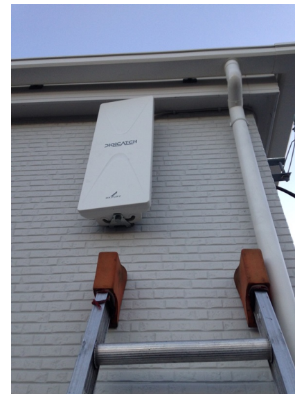
横浜市港北区下田町 壁面取付 デザインアンテナ工事
