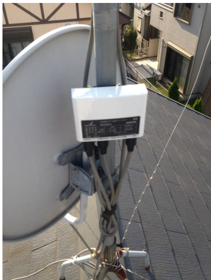
横浜市港北区小机町 ブースター交換工事
