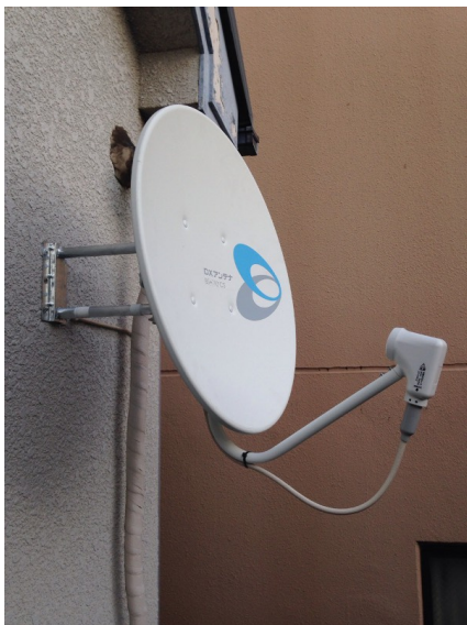
横浜市港北区高田東 壁面取付 BSアンテナ工事
