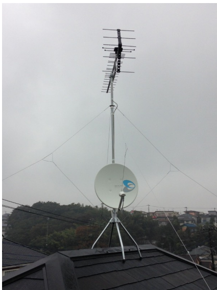
横浜市港北区新吉田東 地デジアンテナとBSアンテナ屋根上工事
