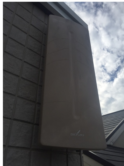
横浜市港北区菊名 壁面取付 デザインアンテナ工事
