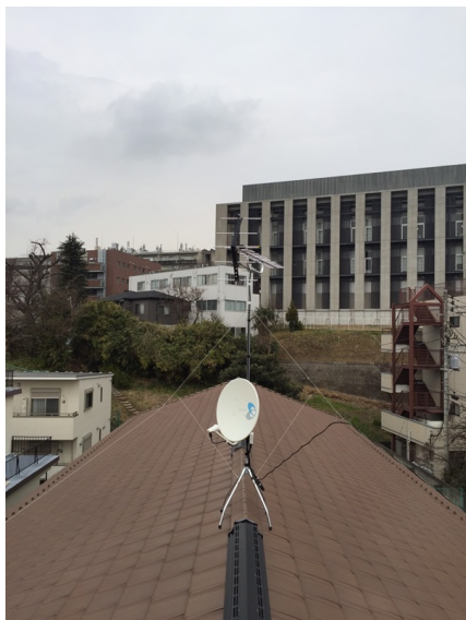
横浜市港北区日吉 地デジアンテナとBSアンテナ屋根上工事
