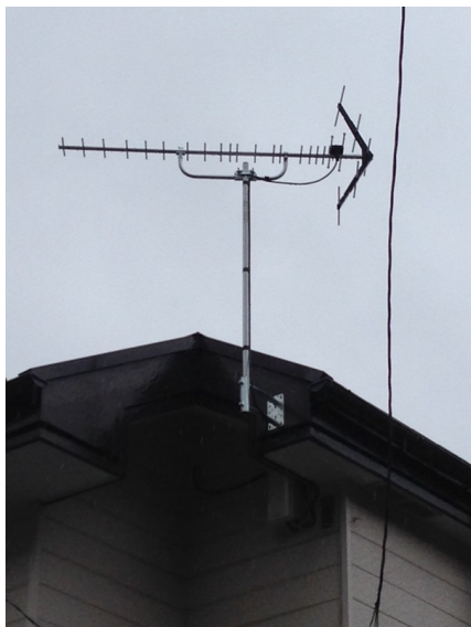
横浜市港北区島山町 壁面取付 地デジアンテナ工事
