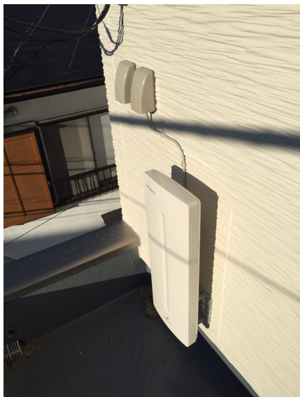
横浜市港北区師岡町 壁面取付 デザインアンテナ工事
