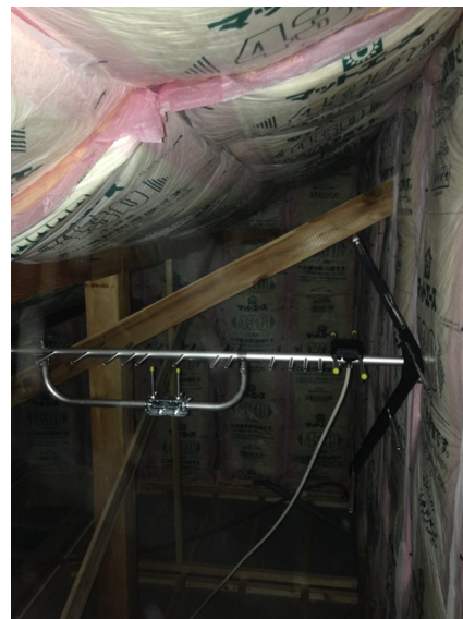
横浜市港北区新吉田東 地デジアンテナ屋根裏工事
