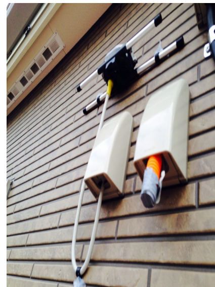
横浜市港北区師岡町 壁面取付 地デジアンテナ工事
