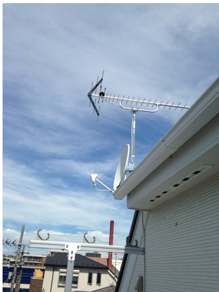
横浜市港北区篠原町 壁面取付 デザインアンテナ 工事
