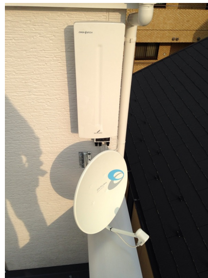
横浜市港北区日吉 壁面取付 デザインアンテナとBSアンテナ工事
