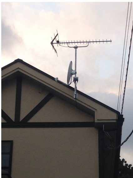
横浜市港北区日吉 壁面取付 地デジアンテナとBSアンテナ工事
