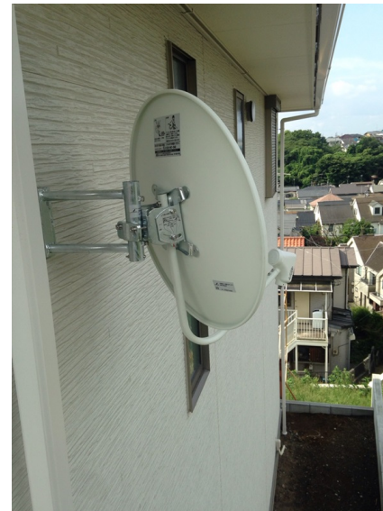
横浜市港北区下田町 大成建設様物件 壁面取付 デザインアンテナ工事
