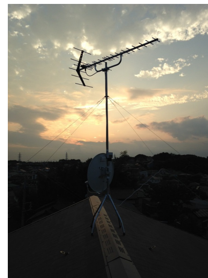
横浜市港北区篠原町 住友林業様物件 地デジアンテナとBSアンテナ屋根上工事
