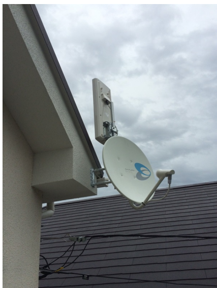
横浜市港北区小机町 ハビタット様物件 壁面取付 デザインアンテナとBSアンテナ工事
