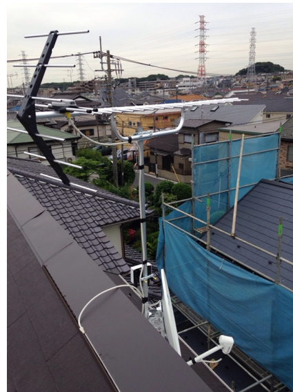
横浜市港北区大曽根 丸山工務店 壁面取付 地デジアンテナとBSアンテナ工事
