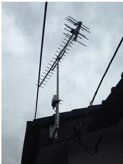
横浜市港北区篠原台町 横浜ホーム様物件 壁面取付 地デジアンテナ工事
