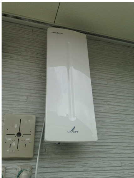
横浜市港北区下田町 大成建設様物件 壁面取付 BSアンテナ工事
