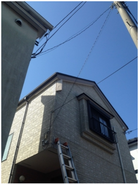
横浜市金沢区富岡西 デザインアンテナ工事後の 外観
