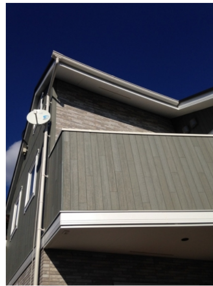
横浜市金沢区西柴 ジューテックホーム様物件 BSアンテナ工事後の外観
