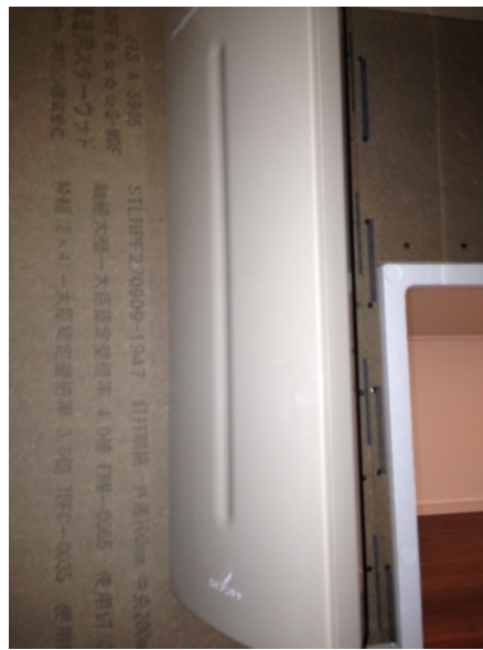
横浜市金沢区富岡西 住友林業様物件 デザインアンテナ屋根裏工事
