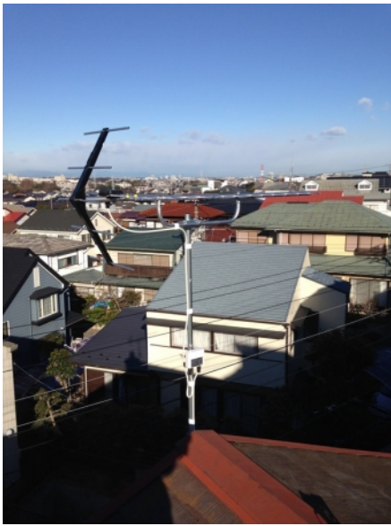
横浜市金沢区富岡西 壁面取付 地デジアンテナ 工事
