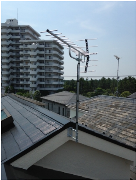
横浜市金沢区柴町 壁面取付 地デジアンテナ工事
