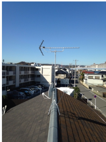
横浜市金沢区野島町 地デジアンテナとBSアンテナ屋根上工事
