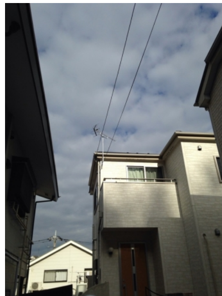
横浜市金沢区富岡西 地デジアンテナ工事後の外観
