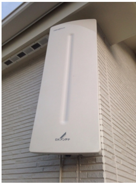
横浜市金沢区六浦東 壁面取付 デザインアンテナ工事
