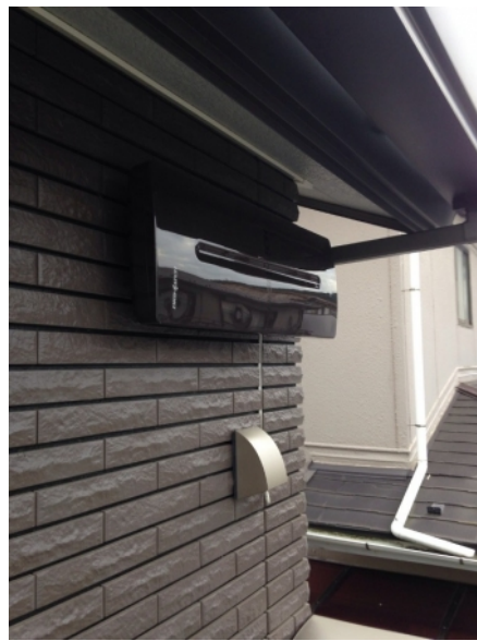
横浜市金沢区釜利谷西 垂直偏波受信 壁面取付 デザインアンテナ工事
