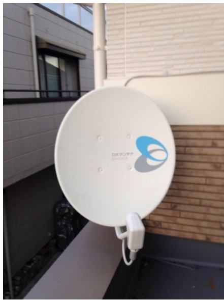
横浜市金沢区六浦東 壁面取付 BSアンテナ工事
