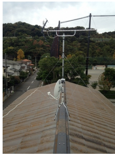
横浜市金沢区釜利谷西 地デジアンテナとBSアンテナ屋根上工事
