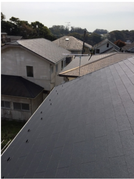
横浜市金沢区長浜 タツミプランニング様物件 壁面取付 地デジアンテナ工事
