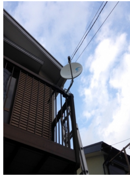
横浜市金沢区富岡西 ベランダ取付 BSアンテナ工事
