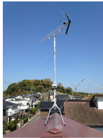
横浜市金沢区金沢町 地デジアンテナ屋根上工事
