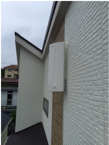
横浜市金沢区長浜 壁面取付 デザインアンテナ 工事
