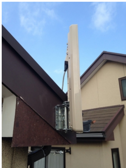
横浜市金沢区平潟町 壁面取付 デザインアンテナ工事
