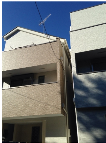
横浜市金沢区柴町 地デジアンテナ工事後の外観
