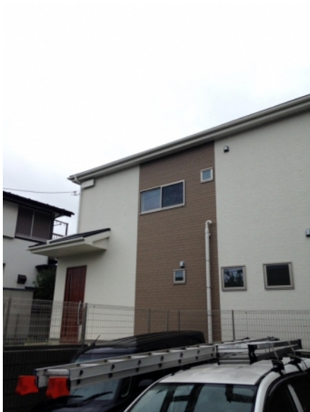
横浜市金沢区釜利谷西 一建設様物件
