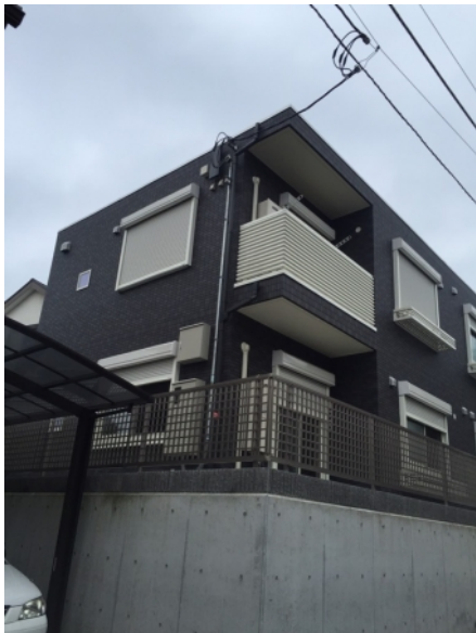
横浜市保土ヶ谷区鎌谷町 デザインアンテナ工事後の外観
