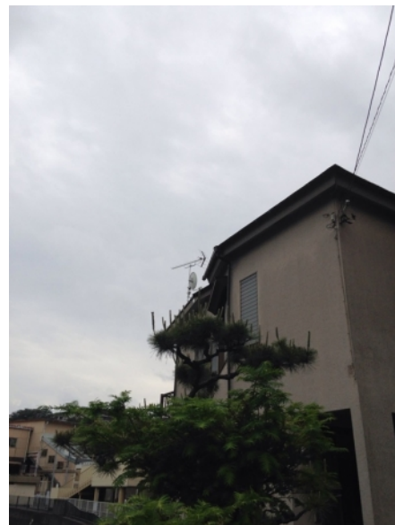
横浜市保土ヶ谷区仏向町 地デジアンテナとBSアンテナ工事後の外観
