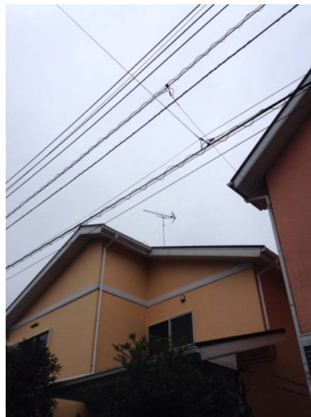
横浜市保土ヶ谷区新桜ヶ丘 地デジアンテナ工事後の外観
