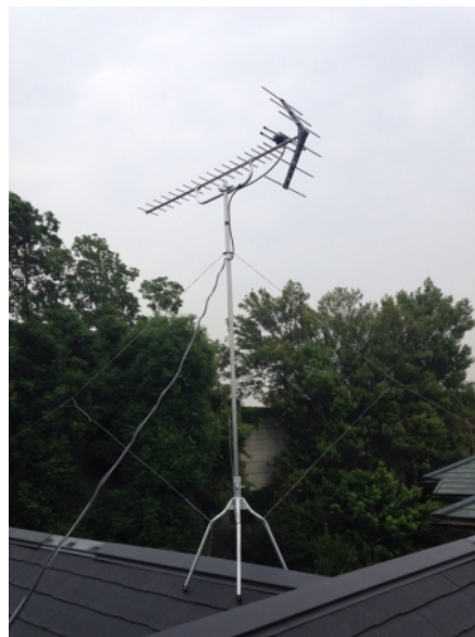
横浜市保土ヶ谷区狩場町 地デジアンテナ屋根上工事
