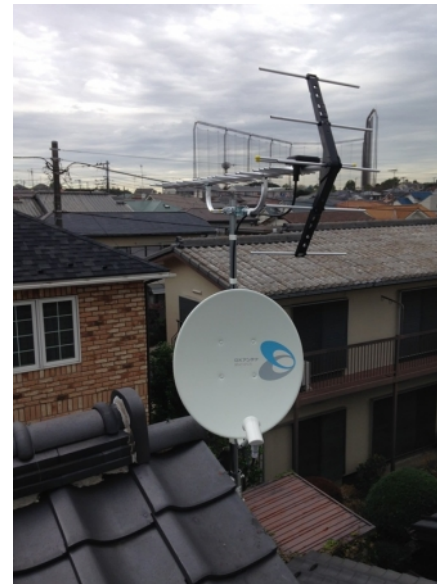
横浜市保土ヶ谷区新桜ヶ丘 壁面取付 地デジアンテナとBSアンテナ工事
