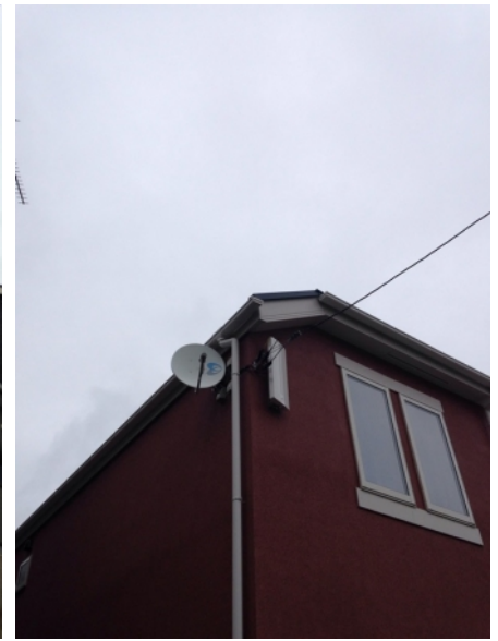
横浜市保土ヶ谷区鎌谷町
