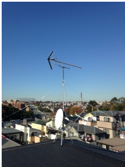
横浜市保土ヶ谷区狩場町 地デジアンテナとBSアンテナ屋根上工事
