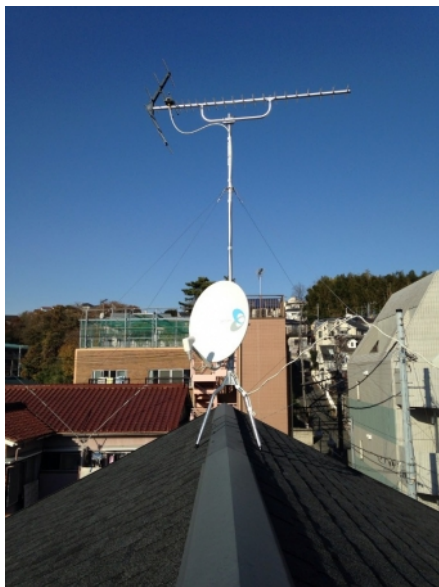
横浜市保土ヶ谷区霞台 地デジアンテナとBSアンテナ屋根上工事
