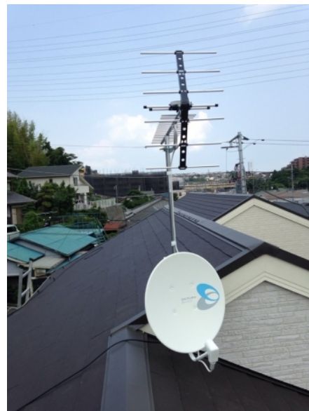
横浜市保土ヶ谷区鎌谷町 壁面取付 地デジアンテナとBSアンテナ工事
