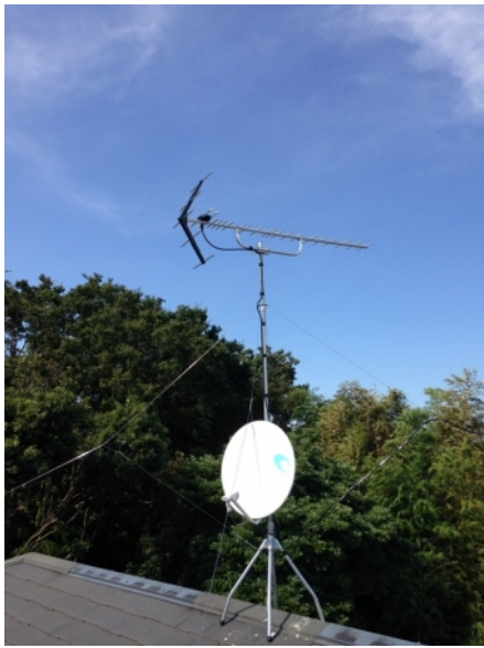
横浜市保土ヶ谷区新井町 地デジアンテナとBSアンテナ屋根上工事
