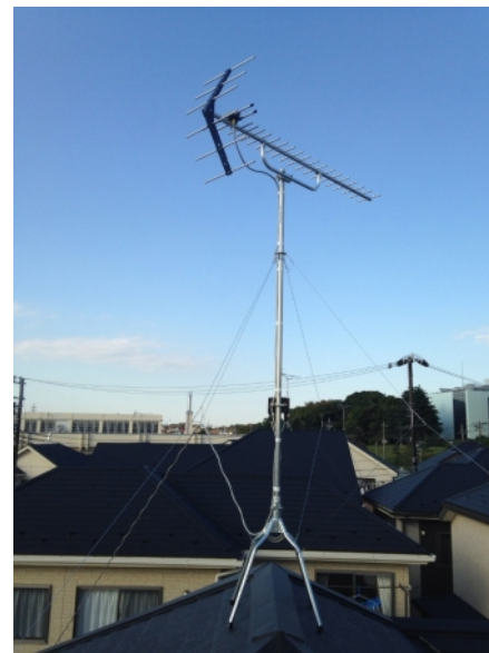
横浜市保土ヶ谷区上菅田町 地デジアンテナ屋根上工事
