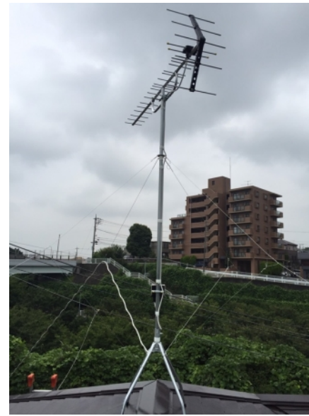
横浜市保土ヶ谷区東川島町 地デジアンテナ屋根上工事
