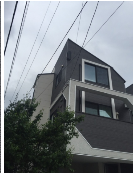
横浜市保土ヶ谷区上星川 三栄建築設計様物件 デザインアンテナ工事後の外観
