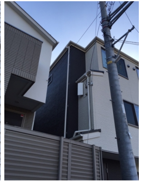
横浜市保土ヶ谷区岩井町 ひかり建設様物件 デザインアンテナ工事後の外観
