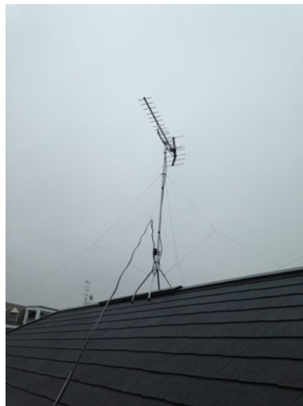
横浜市保土ヶ谷区釜台町 ハウスプラン様物件
