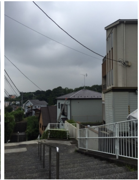
横浜市保土ヶ谷区東川島町 地デジアンテナ工事後の外観
