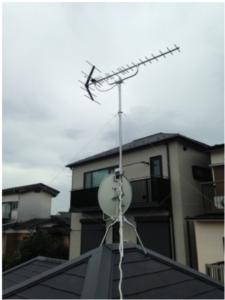
横浜市保土ヶ谷区峰岡町 地デジアンテナとBSアンテナ屋根上工事
