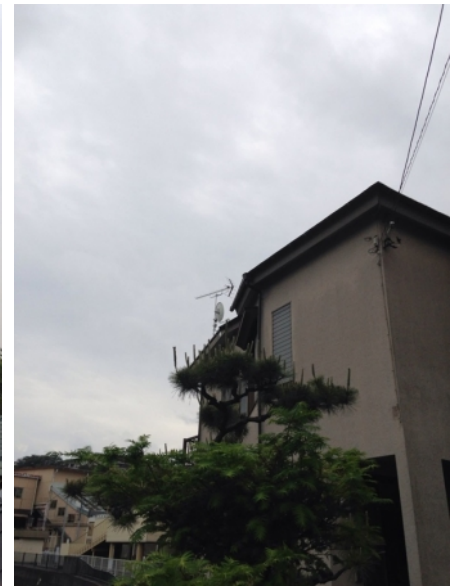
横浜市保土ヶ谷区仏向町 地デジアンテナとBSアンテナ工事後の外観
