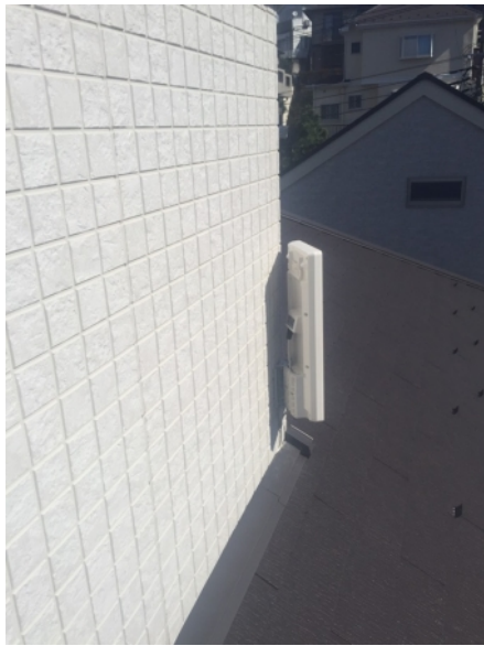
横浜市保土ヶ谷区岡沢町 壁面取付 デザインアンテナ工事
