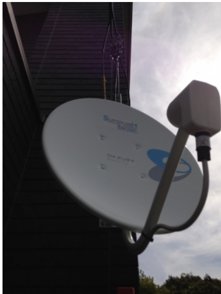
横浜市保土ヶ谷区狩場町 ひかり建設様物件 壁面取付 BSアンテナ工事
