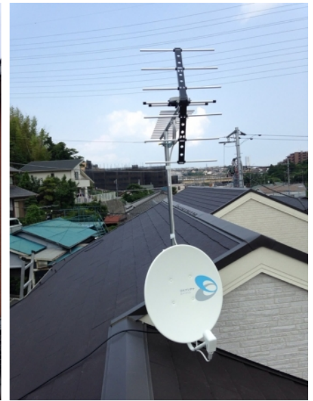
横浜市保土ヶ谷区鎌谷町 壁面取付 地デジアンテナとBSアンテナ工事
