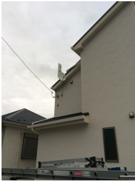
横浜市保土ヶ谷区川島町 津久見建設様物件 デザインアンテナとBSアンテナ工事後の外観
