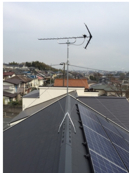
横浜市保土ヶ谷区新桜ヶ丘 桧家住宅様物件
