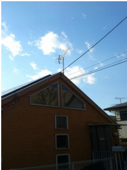
横浜市保土ヶ谷区桜ヶ丘 地デジアンテナ工事後の外観
