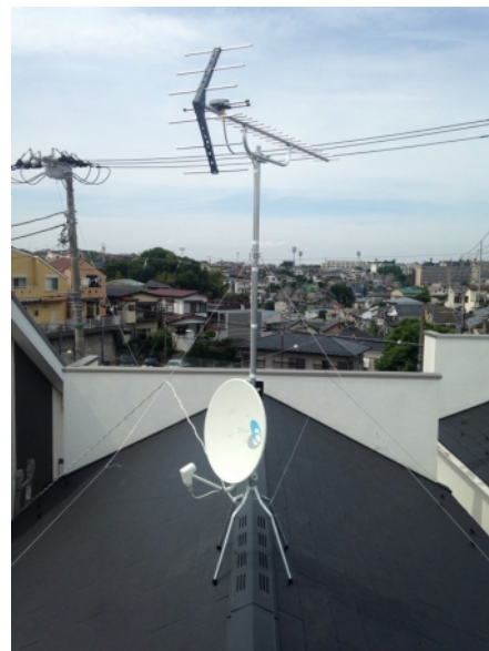
横浜市保土ヶ谷区宮田町 横浜設備様物件
