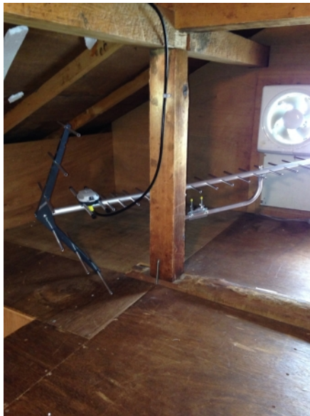
横浜市保土ヶ谷区霞台 地デジアンテナ屋根上工事
