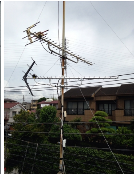
横浜市保土ヶ谷区常盤台 地デジアンテナ追加工事
