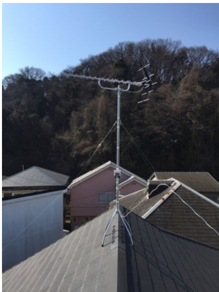
横浜市保土ヶ谷区西谷町 地デジアンテナ屋根上工事
