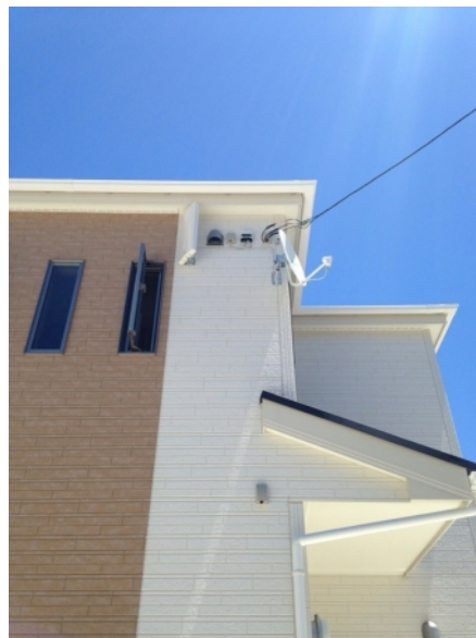
横浜市保土ヶ谷区仏向町 一建設様物件
