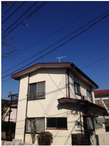
横浜市保土ヶ谷区上星川 地デジアンテナ工事後の外観
