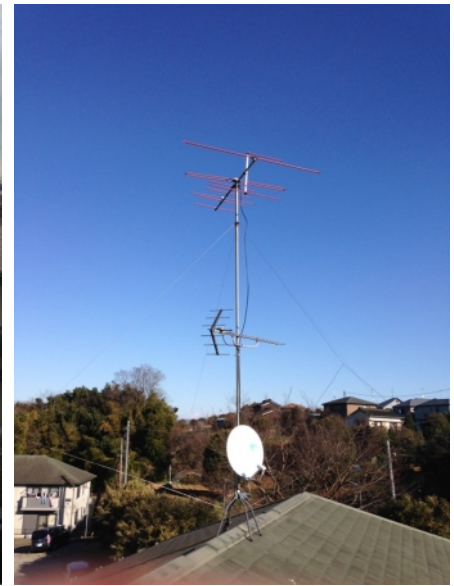
横浜市保土ヶ谷区上菅田町 BSアンテナ追加工事
