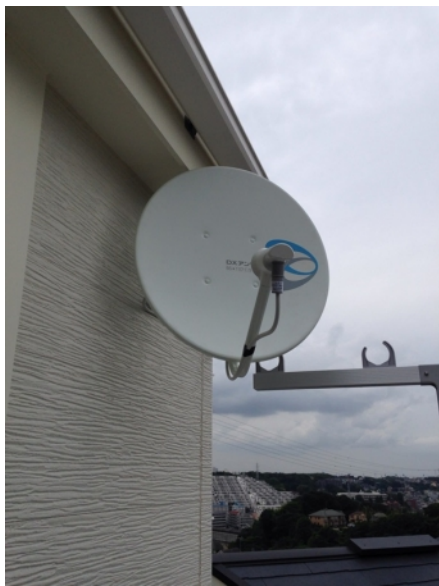
横浜市保土ヶ谷区仏向西 共同建工様物件
