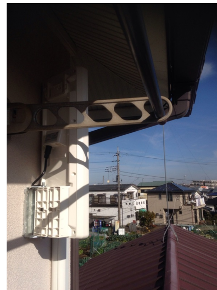
座間市西栗原 壁面取付 デザインアンテナ工事
