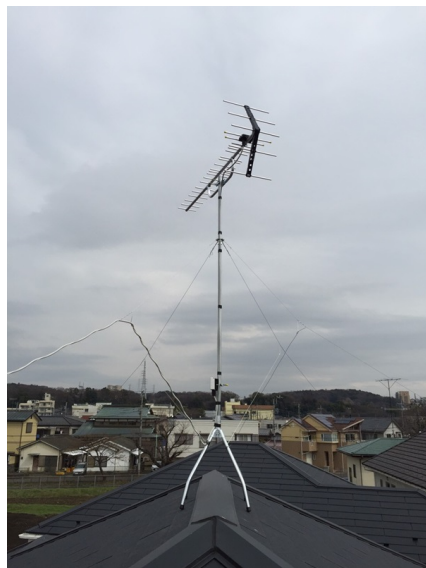
座間市座間 一建設様物件 地デジアンテナ屋根上工事
