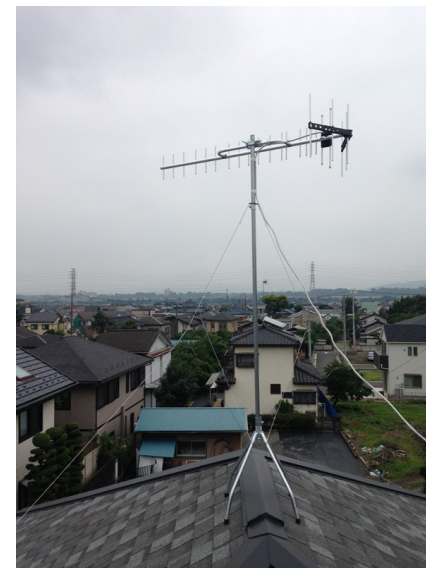
座間市座間 サンケイホーム様物件 垂直偏波受信 地デジアンテナ屋根上工事
