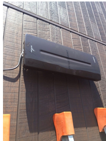
座間市入谷 住宅情報館様物件 垂直偏波受信 壁面取付 デザインアンテナ工事
