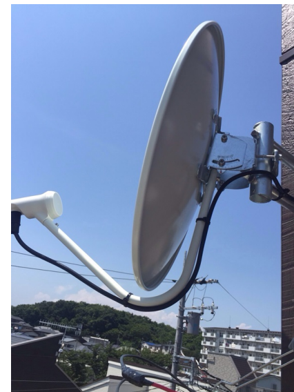
座間市入谷 住宅情報館様物件 壁面取付 BSアンテナ工事
