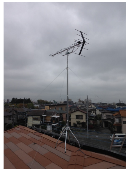
座間市小松原 富士住建様物件 地デジアンテナ屋根上工事
