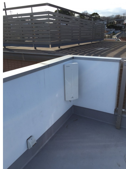
横浜市区百合町 壁面取付 デザインアンテナ工事
