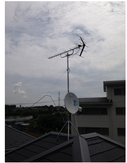
横浜市泉区中田北 地デジアンテナとBSアンテナ工事
