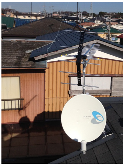
横浜市区上飯田町 地デジアンテナとBS/CSアンテナ工事
