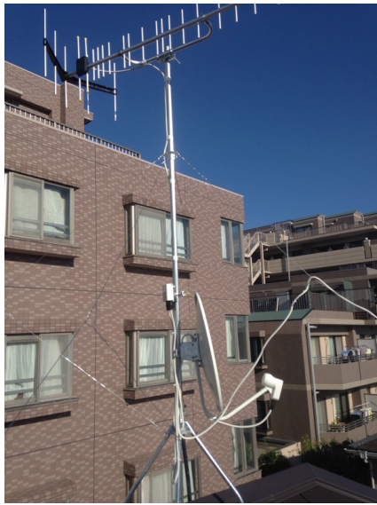
横浜市泉区上飯田町 地デジアンテナとBSアンテナ屋根上工事
