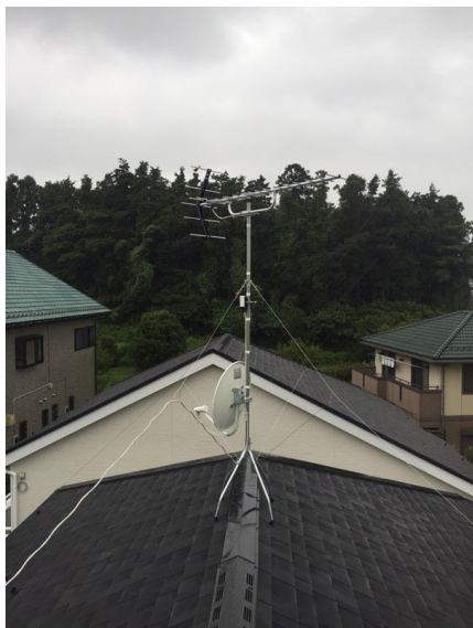
横浜市泉区弥生台 アーネストワン様物件 地デジアンテナとBSアンテナ屋根上工事
