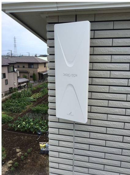
横浜市泉区和泉中央南 一条工務店様物件 壁面取付 デザインアンテナ工事
