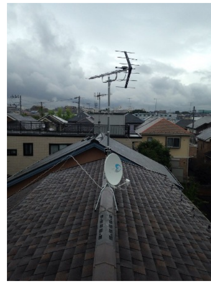
横浜市泉区和泉町 地デジアンテナとBSアンテナ屋根上工事
