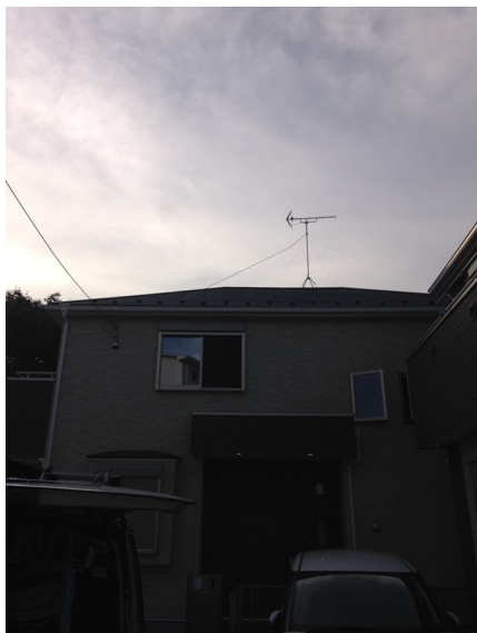
横浜市泉区中田北 弥生建設様物件 地デジアンテナ工事後の外観
