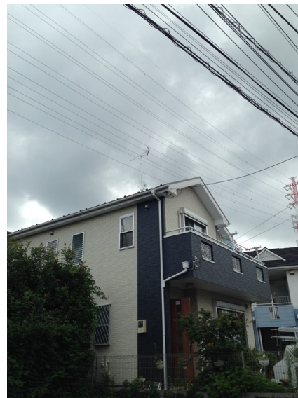
横浜市区中田北 地デジアンテナ屋根上工事
