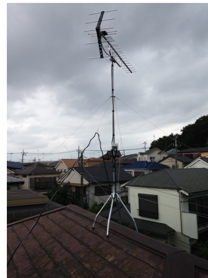
横浜市区中田北 地デジアンテナ工事後の外観
