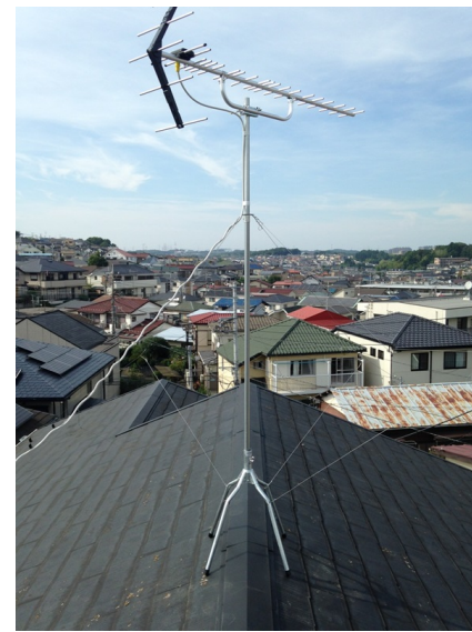
横浜市泉区白百合 地デジアンテナ屋根上工事
