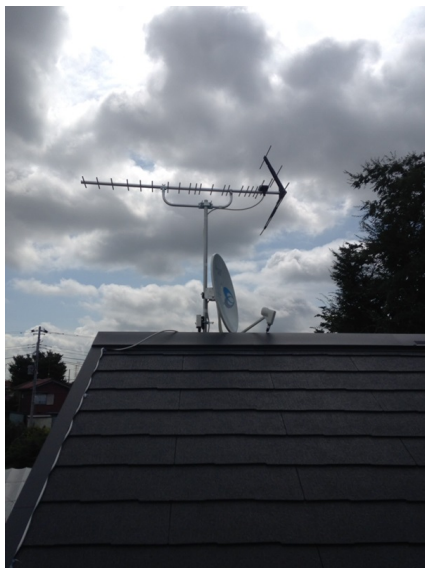
横浜市泉区中田西 アルバホーム様物件 壁面取付 地デジアンテナとBSアンテナ工事
