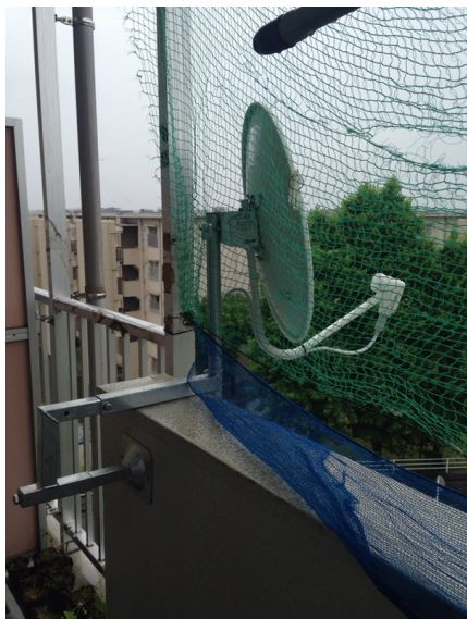
横浜市泉区上飯田町 ベランダ取付 BSアンテナ工事
