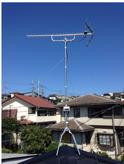
横浜市泉区上飯田町 地デジアンテナ屋根上工事
