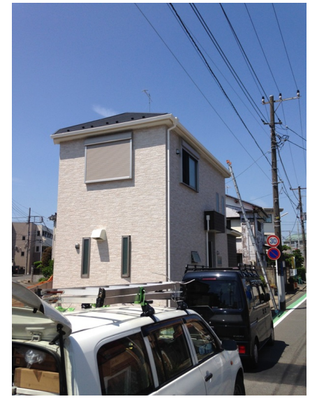
横浜市泉区中田北 弥生建設様物件
