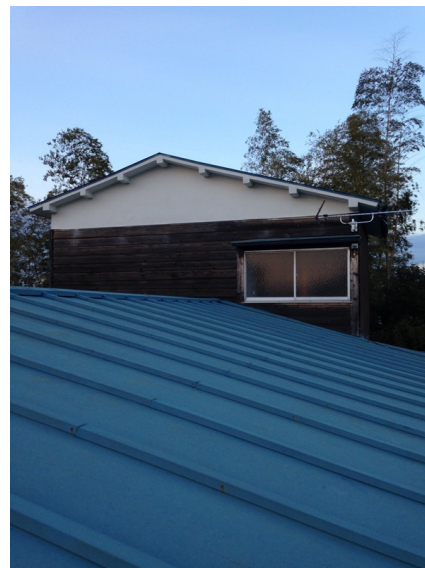
横浜市旭区希望ヶ丘 地デジアンテナとBSアンテナ屋根上工事
