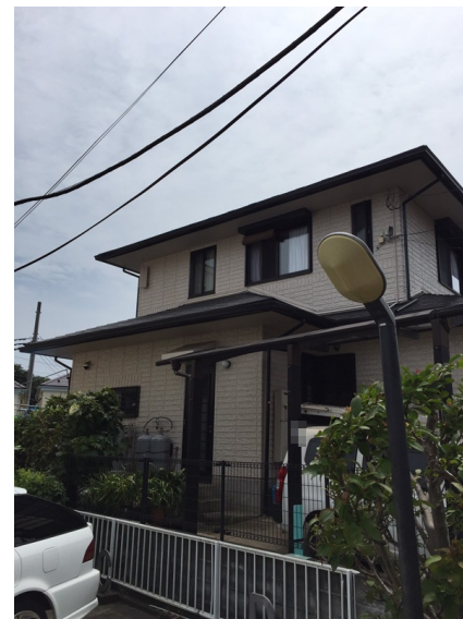
横浜市旭区西川島町 ブースター電源部 ブースター本体
