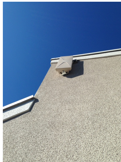
横浜市旭区今宿町 地デジアンテナ屋根上工事
