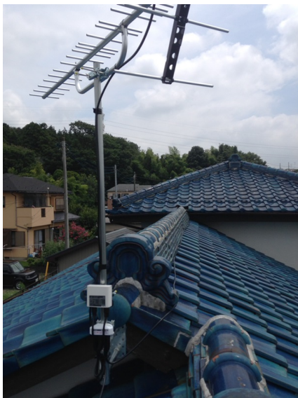
横浜市旭区上川井本町 地デジアンテナ工事後の 外観
