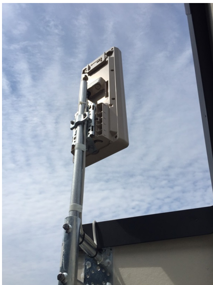
横浜市旭区本宿町 デザインアンテナ工事後の外 観
