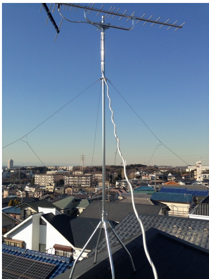
横浜市旭区市沢町 地デジアンテナ工事後の外観
