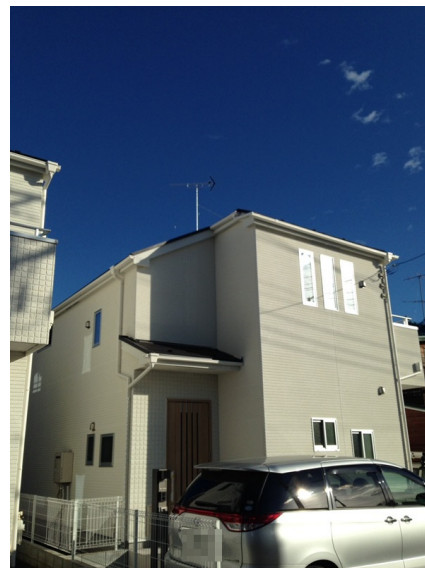
横浜市旭区中沢 壁面取付 デザインアンテナ工事
