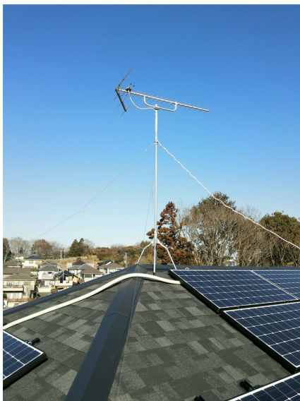
横浜市旭区市沢町 壁面取付 BSアンテナ工事
