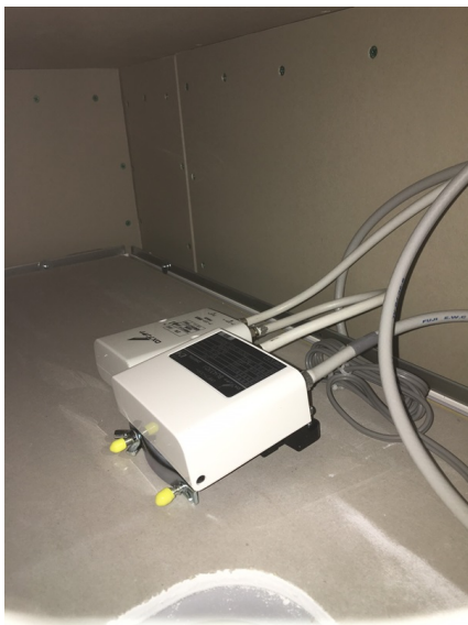
横浜市旭区西川島町 壁面取付 デザインアンテナ工事
