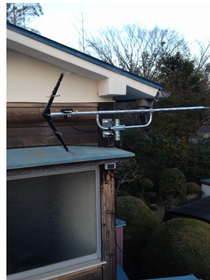
横浜市旭区西川島町 壁面取付 地デジアンテナ工事
