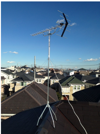
横浜市旭区今宿町 地デジアンテナ工事後の外観
