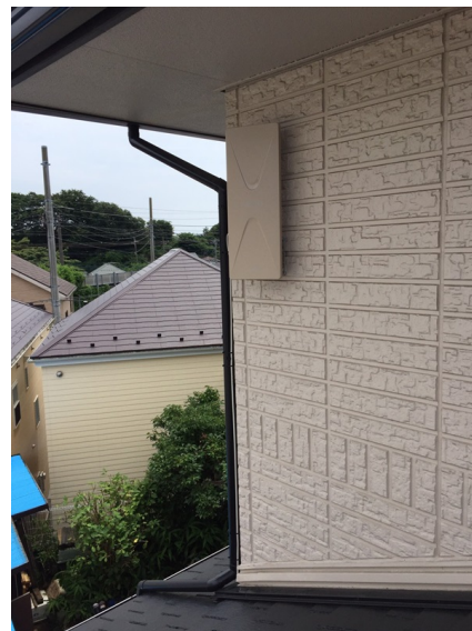
横浜市旭区西川島町 デザインアンテナ工事後の外観
