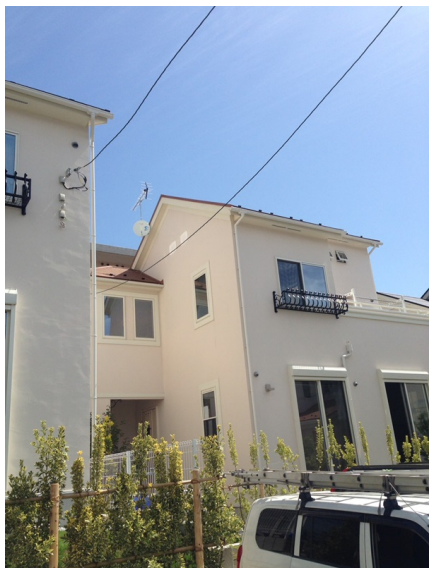
横浜市旭区中希望ヶ丘 壁面取付 地デジアンテナ工事
