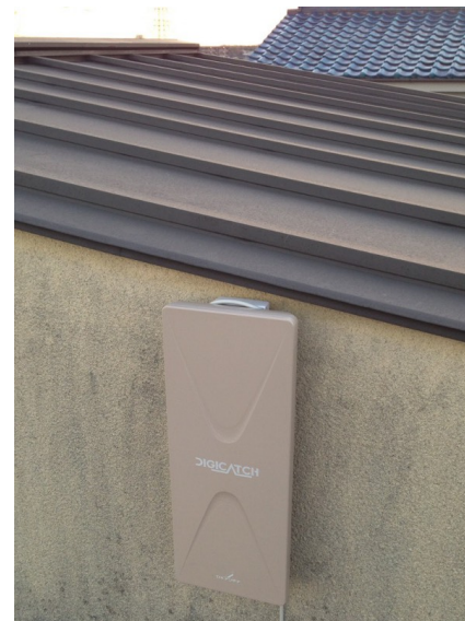
横浜市旭区鶴ヶ峰本町 地デジアンテナ屋根上工事
