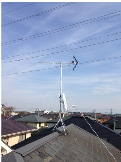
横浜市旭区川井本町 地デジアンテナ工事後の外観
