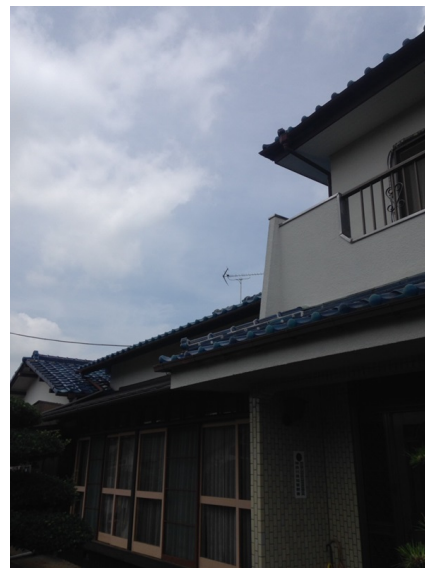
横浜市旭区笹野台 デザインアンテナ工事後の外 観
