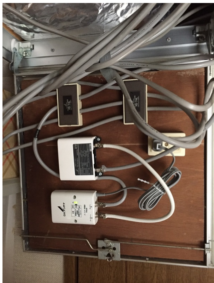
横浜市旭区本宿町 壁面取付 デザインアンテナ 工事
