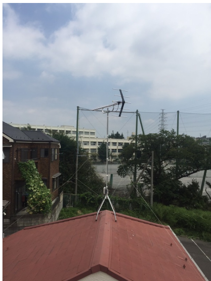
横浜市旭区市沢町 地デジアンテナ屋根上工事
