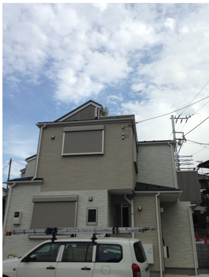
横浜市旭区上川井本町 壁面取付 地デジアンテ ナ工事
