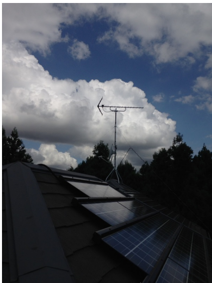
横浜市旭区桐が作 地デジアンテナとBSアンテナ工事
