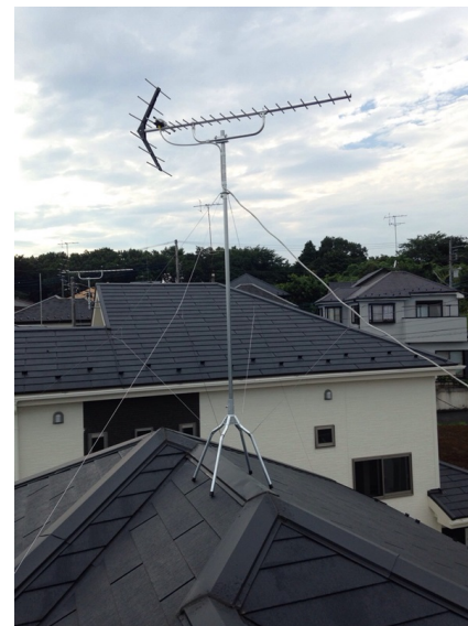
横浜市旭区都岡町 地デジアンテナ屋根上工事
