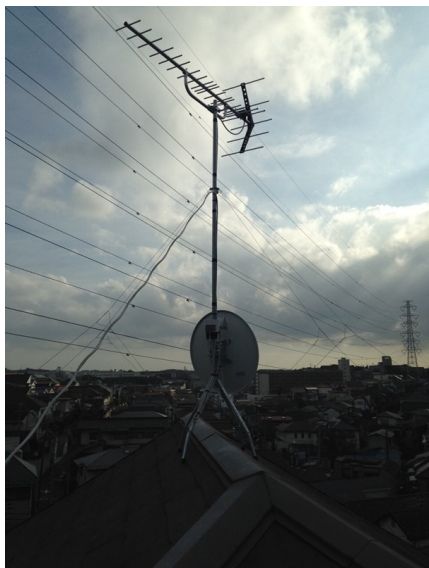
横浜市旭区都岡町 壁面取付 地デジアンテナとBSアンテナ工事
