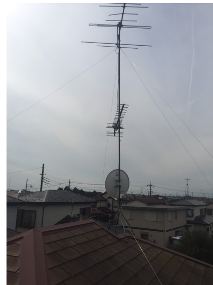
横浜市旭区中沢 地デジアンテナとBSアンテナ屋根上工事
