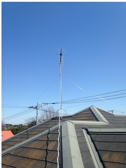
横浜市旭区白根 地デジアンテナの屋根上設置
