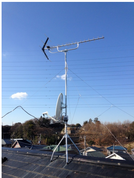
横浜市旭区二俣川 地デジアンテナとBS/CSアンテナの屋根上設置
