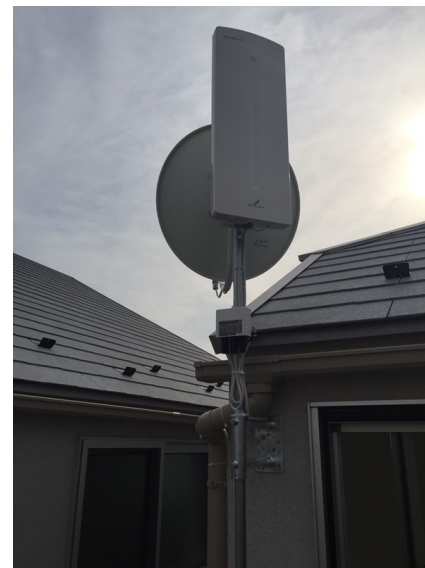
横浜市旭区二俣川 デザインアンテナとBSアンテナ工事後の外観
