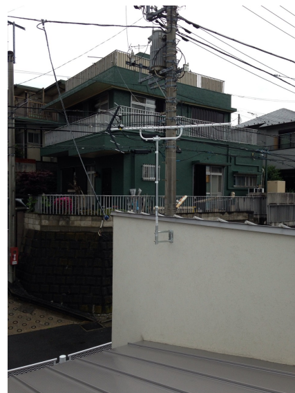
横浜市旭区東希望ヶ丘 壁面取付 地デジアンテナ工事
