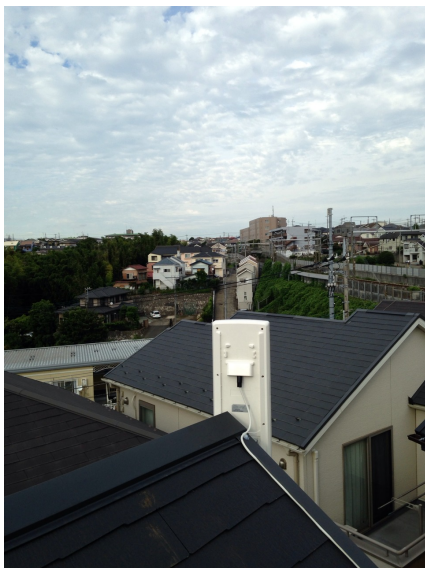
横浜市旭区川島町 壁面取付 デザインアンテナ 工事
