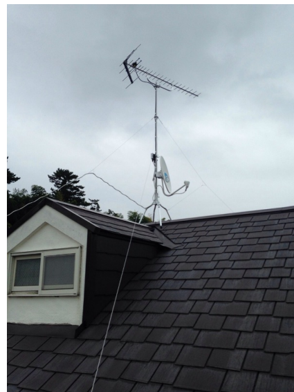
横浜市旭区柏町 地デジアンテナとBSアンテナ屋根上工事
