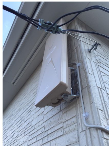
横浜市旭区中尾 一建設様物件 壁面取付 デザインアンテナ工事
