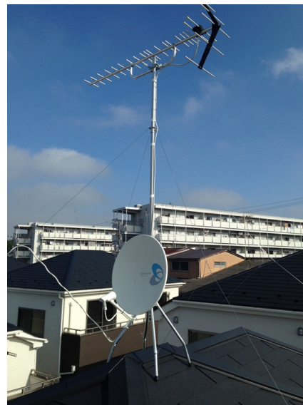
横浜市旭区川井宿町 一建設様物件 地デジアンテナとＢＳアンテナ屋根上工事
