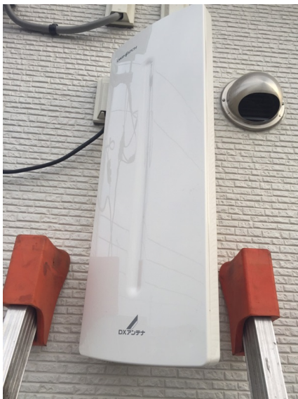
横浜市旭区白根 真和産業様物件 壁面取付 デザインアンテナ工事
