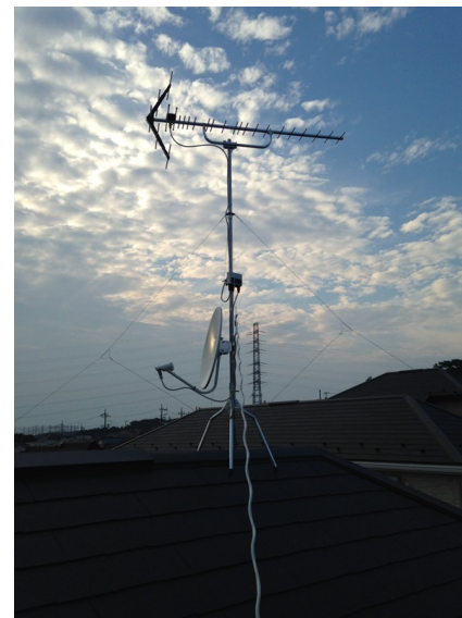
横浜市旭区鶴ヶ峰本町 関本工務店様物件 地デジアンテナとBSアンテナ屋根上工事
