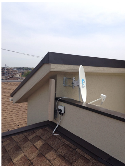
横浜市旭区善部町 エステーホーム様物件 壁面取付 デザインアンテナとBSアンテナ工事
