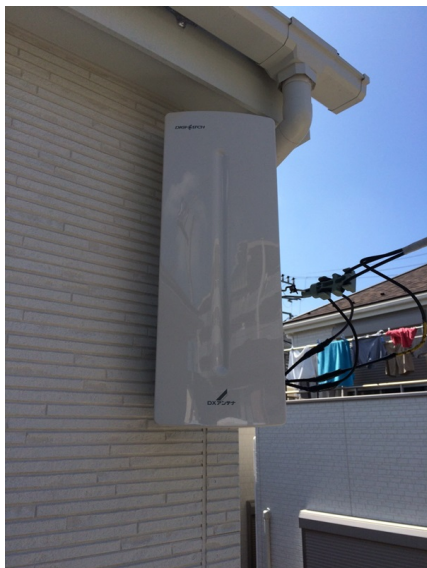
横浜市旭区白根 飯田産業様物件 壁面取付 デザインアンテナ工事
