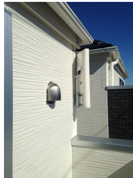
横浜市旭区東希望が丘 ひかり建設様物件 壁面取付 デザインアンテナ工事
