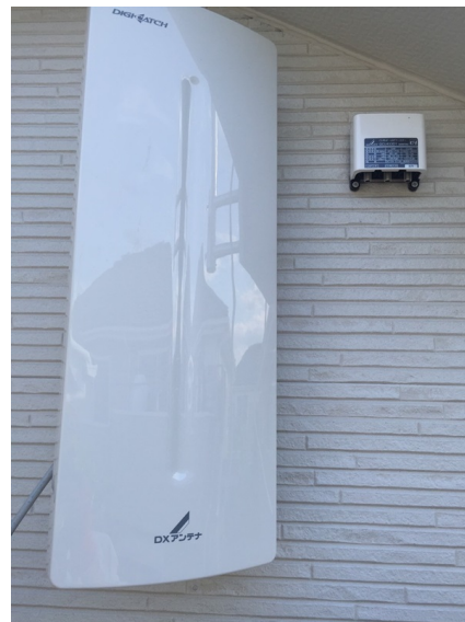
横浜市旭区今宿町 一建設様物件 壁面取付 デザインアンテナ工事
