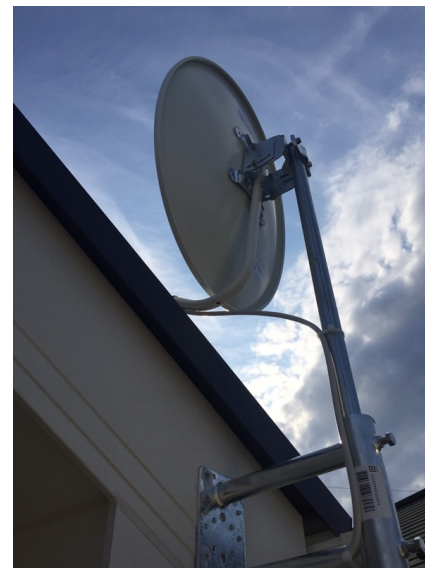
横浜市旭区今宿町 一建設様物件 壁面取付 BSアンテナ工事
