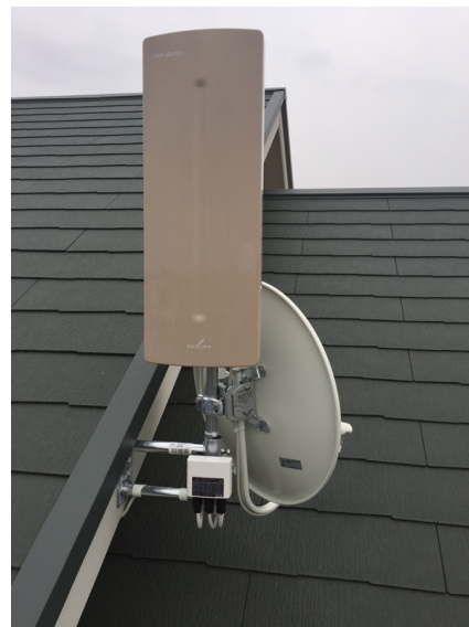
横浜市旭区中希望が丘 兼六ホーム様物件 壁面取付 デザインアンテナとBSアンテナ工事
