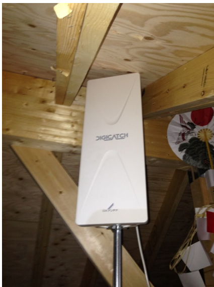
横浜市旭区南希望が丘 工藤建設様物件 デザインアンテナ屋根裏工事
