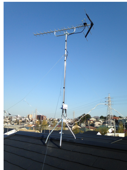
横浜市旭区本村町 あさひハウジング様ご物件 屋根上設置 八木式アンテナ工事
