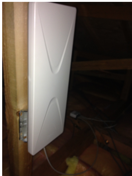
横浜市旭区 屋根裏設置 デザインアンテナ工事
