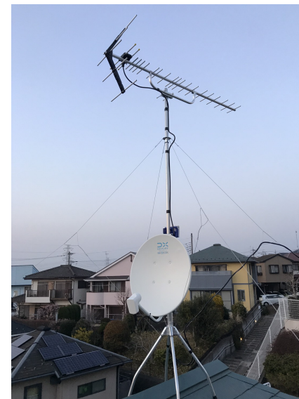
横浜市旭区今宿町 屋根上設置 八木式アンテナとBS/CSアンテナ工事
