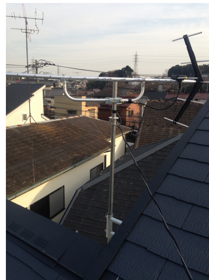
旭区三反田町 破風板取付 八木式アンテナ工事
