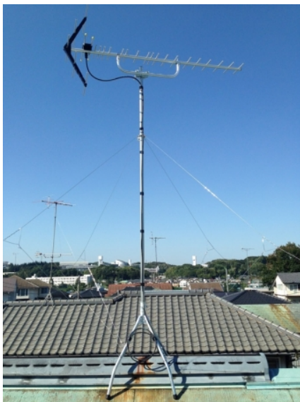
横浜市青葉区みたけ台 地デジアンテナ屋根上工事
