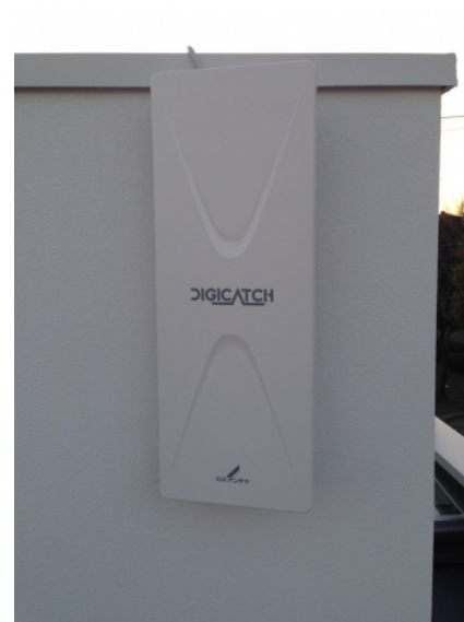
横浜市青葉区奈良町 壁面取付 デザインアンテナ工事
