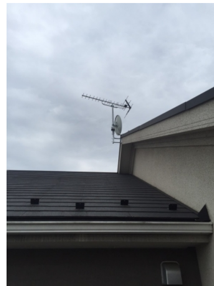
横浜市青葉区桂台 壁面取付 地デジアンテナとBSアンテナ工事
