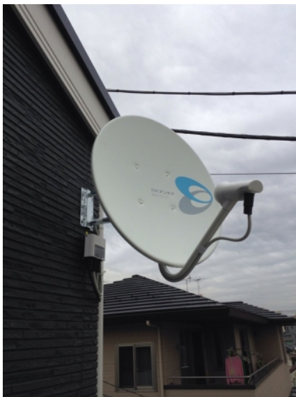
横浜市青葉区しらとり台 壁面取付 BSアンテナ工事
