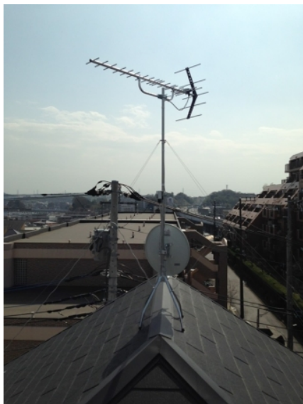
横浜市青葉区新石川 地デジアンテナとBSアンテナ屋根上工事
