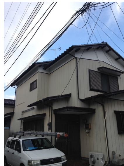
大和市下和田 地デジアンテナ工事後の外観
