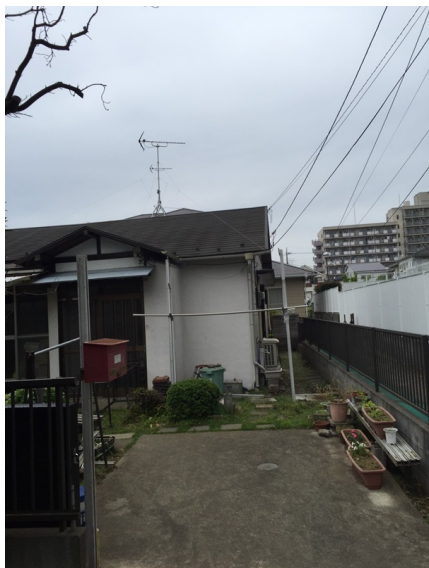
大和市深見西 地デジアンテナ工事後の外観
