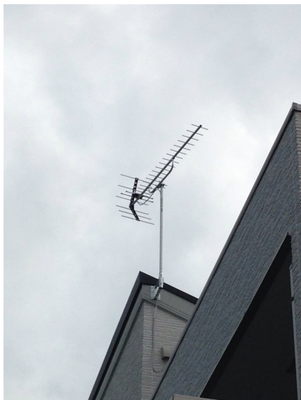
大和市西鶴間 壁面取付 地デジアンテナ工事
