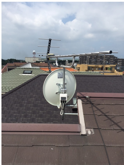
大和市福田 BSアンテナ追加工事
