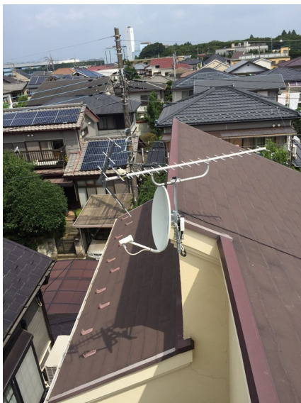
大和市福田 BSアンテナ追加工事
