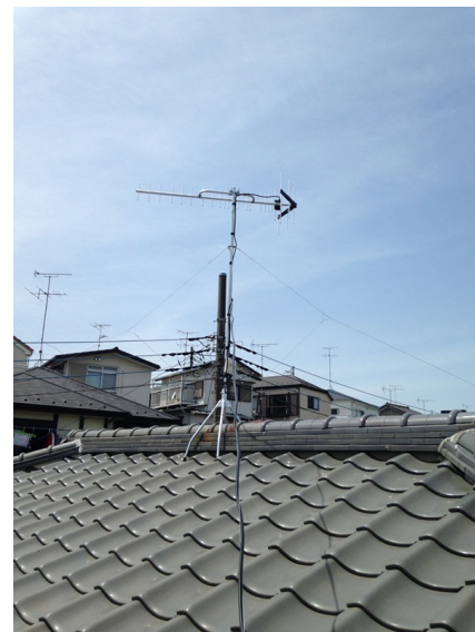
大和市福田 垂直偏波受信 地デジアンテナ屋根上工事
