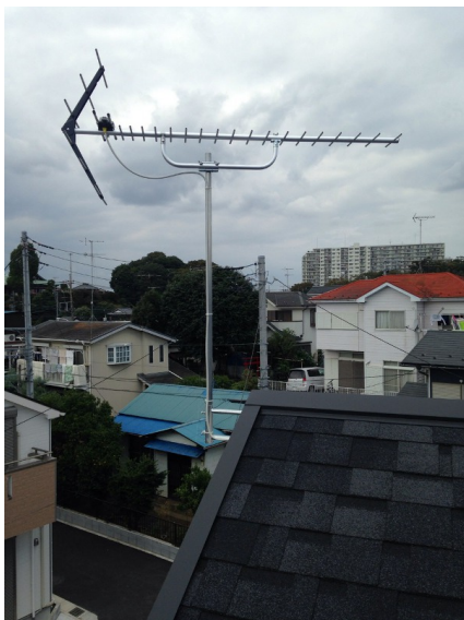
大和市下鶴間 壁面取付 地デジアンテナ工事
