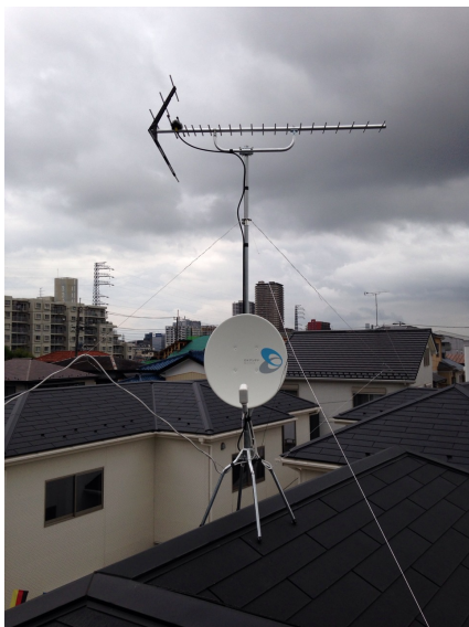
大和市下和田 地デジアンテナとBSアンテナ屋根上工事
