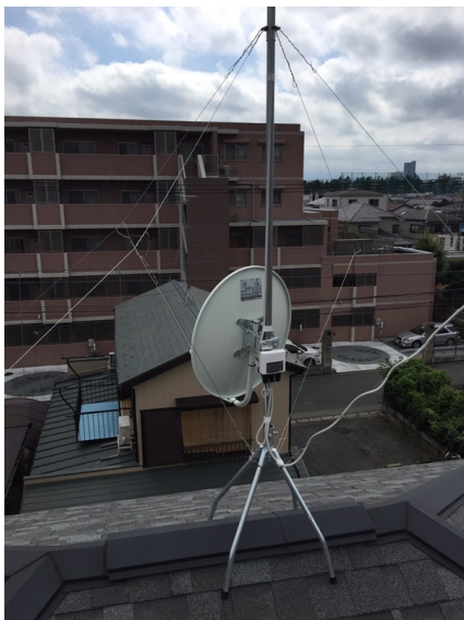
大和市中央林間 BSアンテナ追加工事
