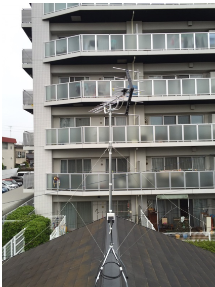
大和市深見西 地デジアンテナ屋根上工事
