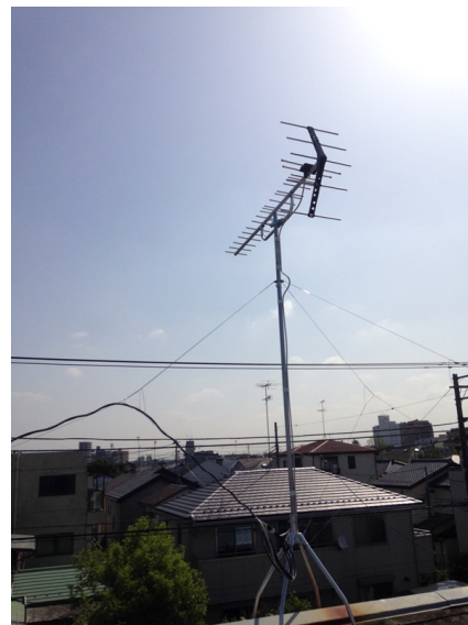
大和市南林間 地デジアンテナ屋根上工事
