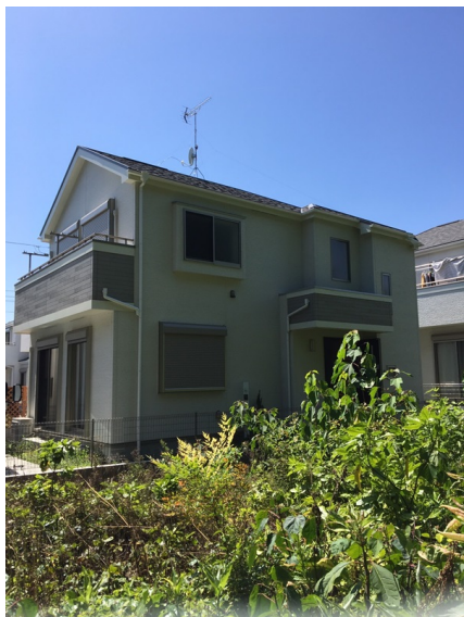
大和市中央林間西 地デジアンテナとBSアンテナ工事後の外観
