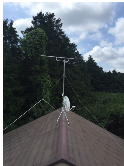
大和市下鶴間 地デジアンテナとBSアンテナ屋根上工事
