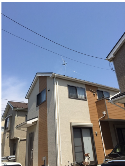
大和市中心林間西 地デジアンテナ工事後の外観
