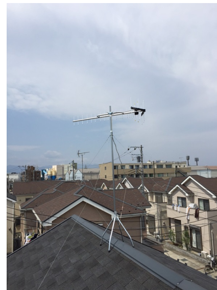
大和市中心林間西 垂直偏波受信 地デジアンテナ屋根上工事
