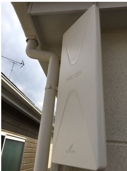
大和市柳橋 壁面取付 デザインアンテナ工事
