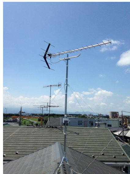
大和市代官 地デジアンテナ屋根上工事
