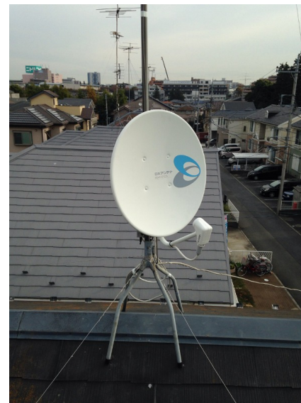
大和市下鶴間 BSアンテナ追加工事
