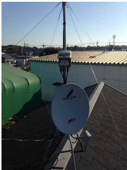
大和市上草柳 ブースター交換工事
