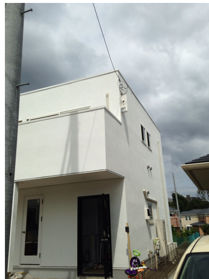
大和市下鶴間 デザインアンテナ工事後の外観
