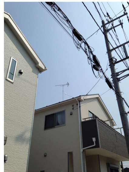
大和市上草柳 地デジアンテナ工事後の外観
