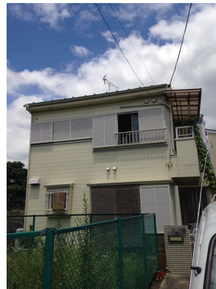
大和市福田 壁面取付 地デジアンテナ工事後の外観
