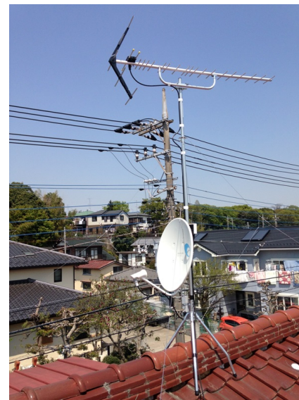
大和市深見 地デジアンテナとBSアンテナ屋根上工事
