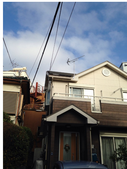
大和市中中央林間 地デジアンテナ工事の外観
