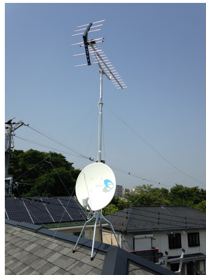
大和市福田 地デジアンテナとBSアンテナ屋根上工事
