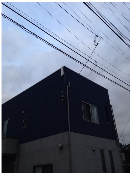
大和市西鶴間 デザインアンテナ工事後の外観
