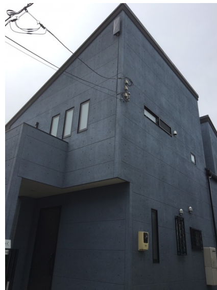
大和市下鶴間 壁面取付 デザインアンテナ工事
