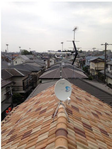
大和市西鶴間 地デジアンテナとBSアンテナ屋根上工事
