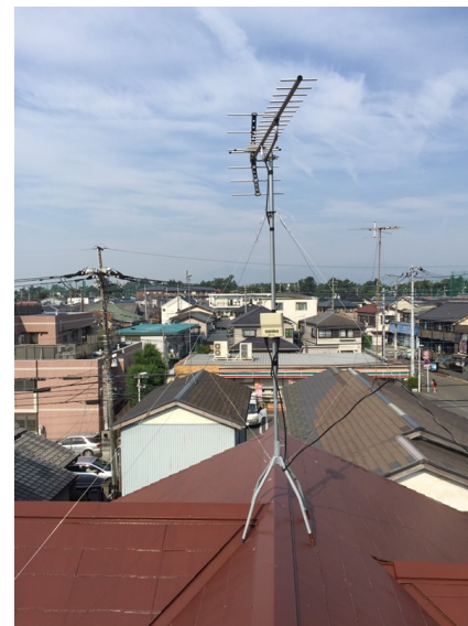
大和市中央林間 地デジアンテナ屋根上工事
