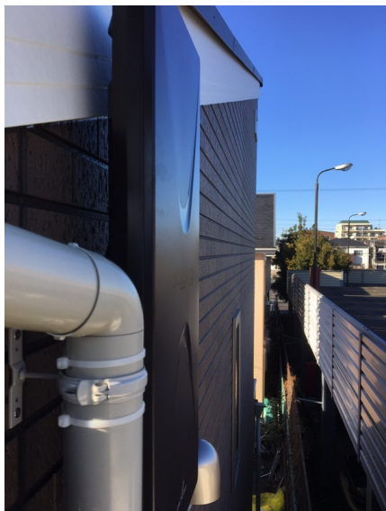
大和市上草柳 壁面取付 デザインアンテナ工事
