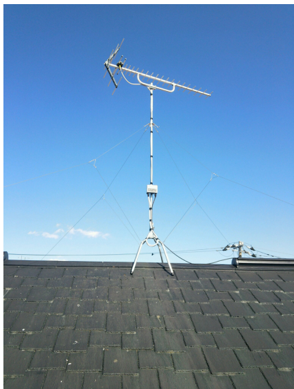
大和市上草柳 地デジアンテナ屋根上工事
