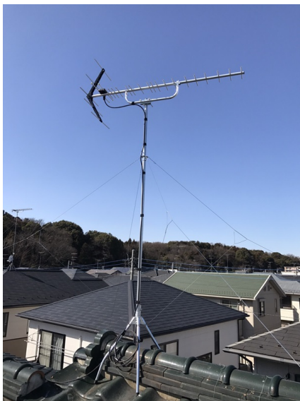
大和市上和田 地デジアンテナ屋根上工事
