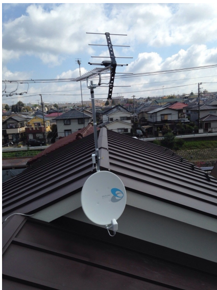
大和市西鶴間 地デジアンテナ屋根上工事
