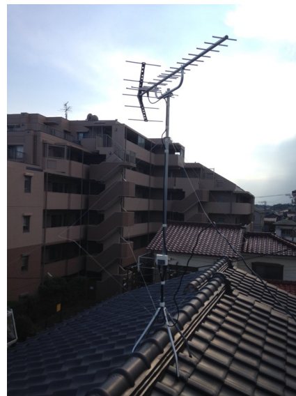
大和市下和田 地デジアンテナ屋根上工事
