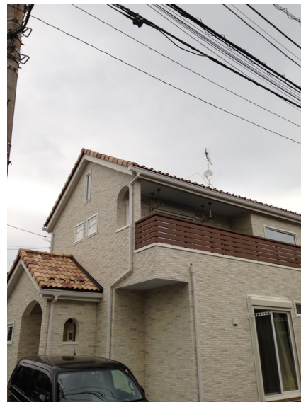
大和市福田 壁面取付 デザインアンテナ工事
