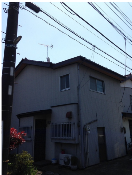
大和市深見 地デジアンテナとBSアンテナ工事後の外観
