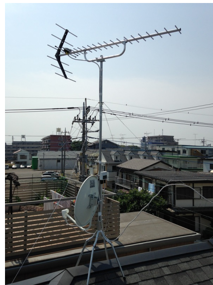
大和市中央 地デジアンテナ工事後の外観
