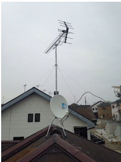
大和市上草柳 地デジアンテナとBSアンテナ工事
