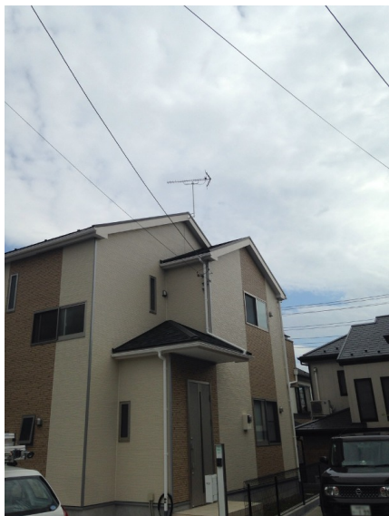
大和市下鶴間 地デジアンテナ工事後の外観
