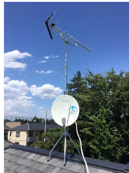
大和市中心林間西 地デジアンテナとBSアンテナ屋根上工事
