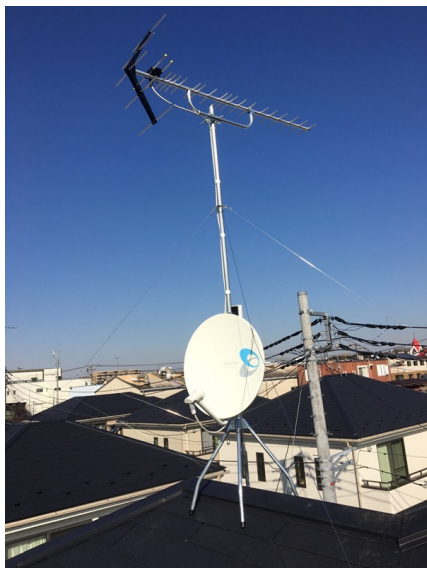
大和市上草柳 一建設様物件 地デジアンテナとBSアンテナ屋根上工事
