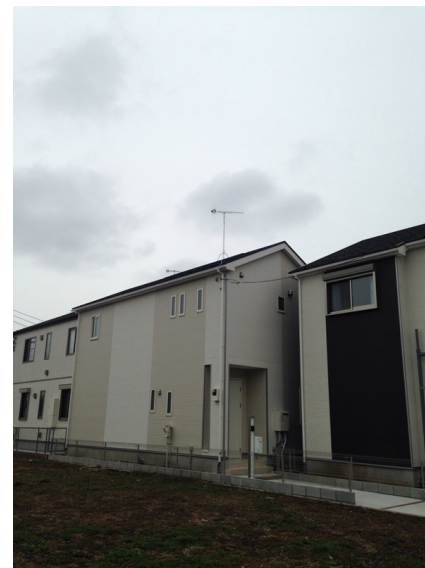
大和市中央林間 飯田産業様物件 地デジアンテナ屋根上工事
