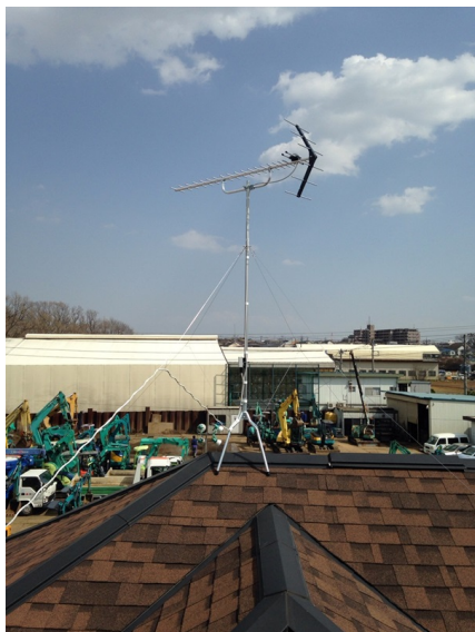
大和市上和田 サンケイホーム様物件 地デジアンテナ屋根上工事
