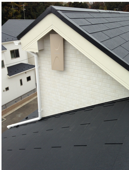
大和市上和田 壁面取付 デザインアンテナ工事
