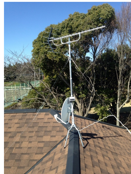
大和市上和田 一建設様物件 垂直偏波受信 地デジアンテナ屋根上工事
