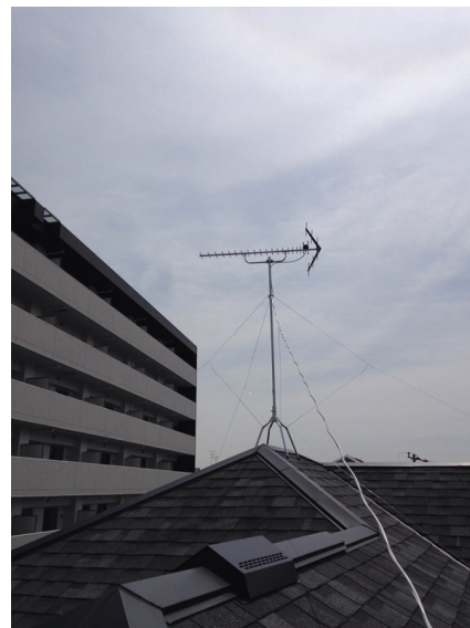
大和市つきみ野 サンケイホーム様物件 地デジアンテナ屋根上工事
