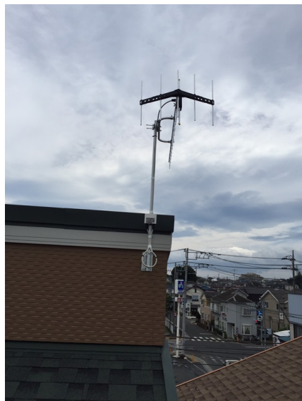
大和市上和田 住宅情報館様物件 垂直偏波受信 壁面取付 地デジアンテナ工事
