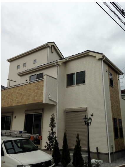
大和市上和田 デザインアンテナ工事後の外観
