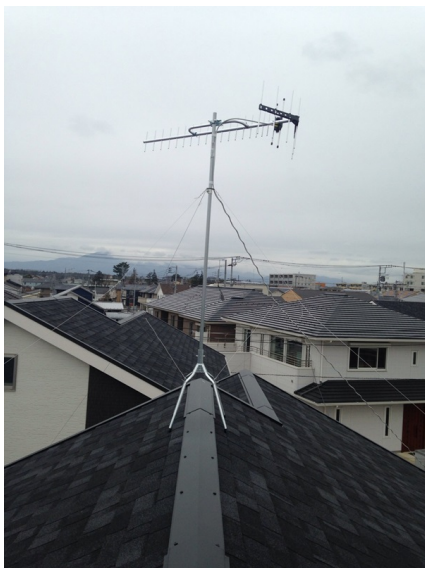
大和市下和田 アーネストワン様物件 垂直偏波受信 地デジアンテナ屋根上工事
