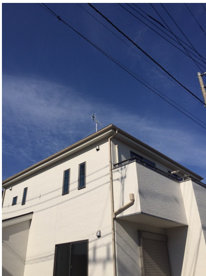
大和市上草柳 一建設様物件 地デジアンテナ工事後の外観
