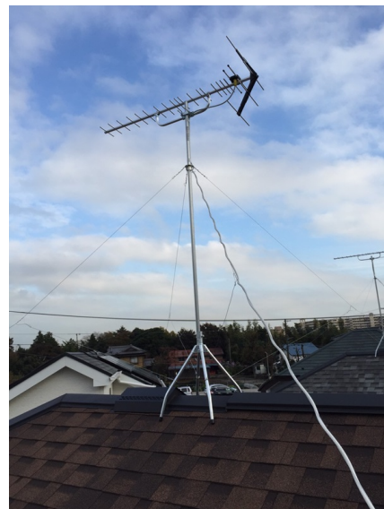
大和市下鶴間 飯田産業様物件 地デジアンテナ屋根上工事
