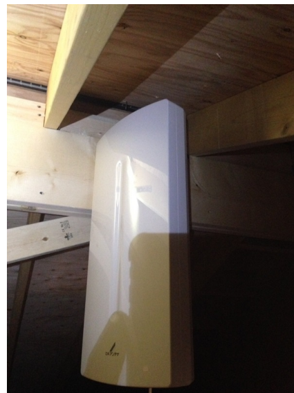
大和市大和東 鹿児島建設様物件 デザインアンテナ屋根裏工事
