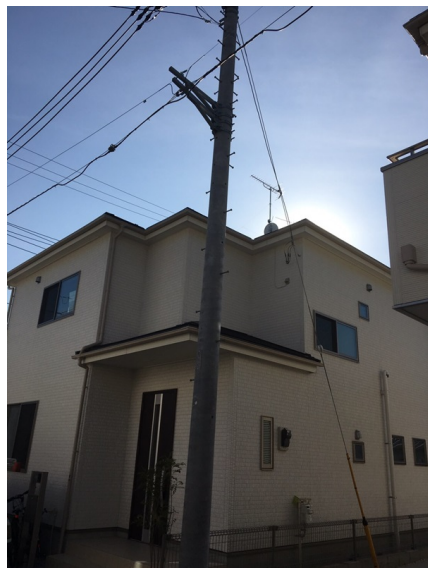
大和市上草柳 一建設様物件 地デジアンテナとBSアンテナ工事後の外観
