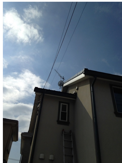
大和市下和田 三井ホーム様物件 地デジアンテナとBSアンテナ後の外観
