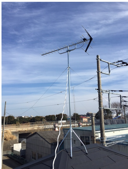
大和市上草柳 一建設様物件 地デジアンテナ屋根上工事
