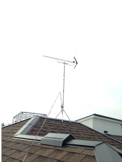
大和市下鶴間 サンケイホーム様物件 地デジアンテナ屋根上工事
