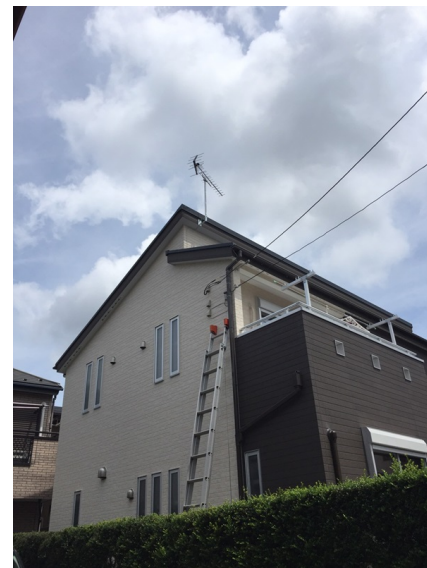
大和市西鶴間 厚木地所様物件 地デジアンテナ工事後の外観
