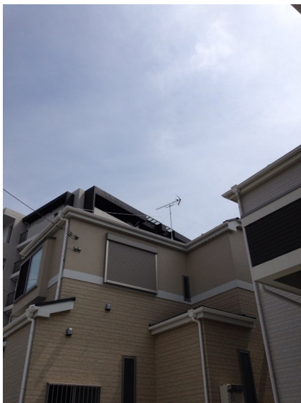
大和市つきみ野 サンケイホーム様物件 地デジアンテナ工事後の外観
