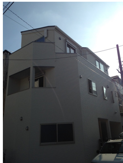
大和市西鶴間 厚木地所様物件 地デジアンテナ屋根上工事
