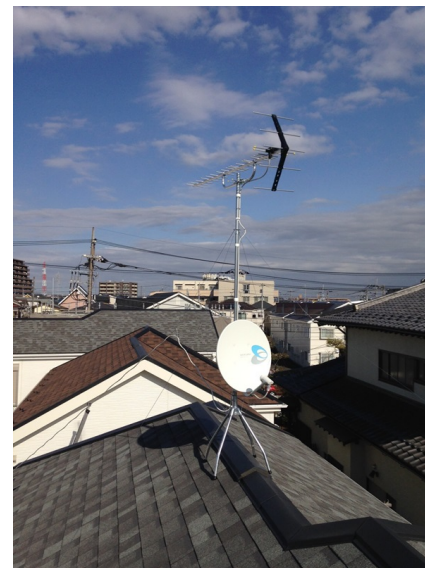
大和市柳橋 飯田産業様物件 地デジアンテナとBSアンテナ屋根上工事
