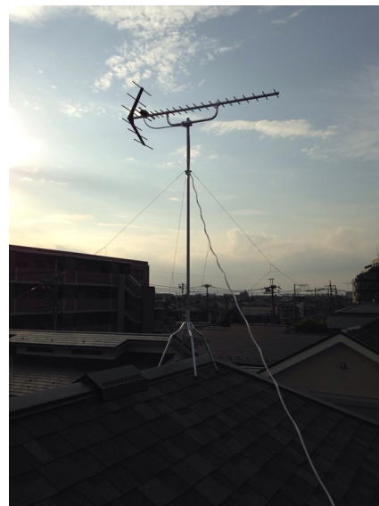
大和市下和田 アーネストワン様物件 地デジアンテナ工事後の外観
