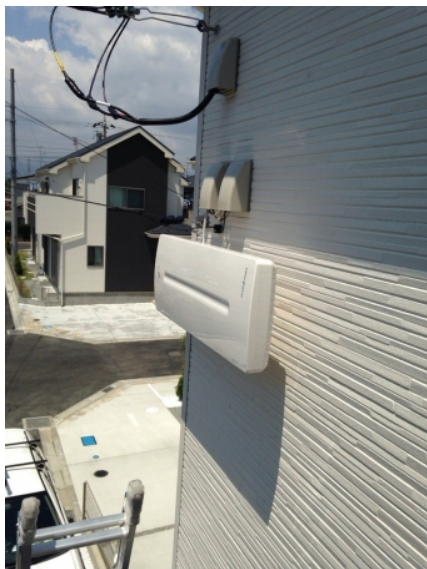
寒川町中瀬 垂直偏波受信 壁面取付 デザインアンテナ工事
