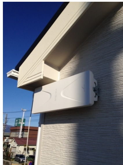
寒川町倉見 東栄住宅様物件 垂直偏波受信 壁面取付 デザインアンテナ工事
