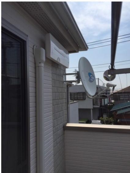
寒川町小動 東栄住宅様物件 垂直偏波受信 壁面取付 デザインアンテナとB Sアンテナ工事
