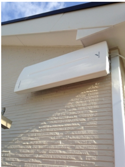
寒川町小谷 垂直偏波受信 壁面取付 デザインアンテナ工事
