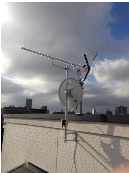
相模原市南区上鶴間本町 壁面取付 地デジアンテナとBSアンテナ工事
