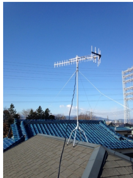
相模原市南区磯部 垂直偏波受信 地デジアンテナ屋根上工事
