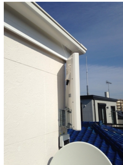
相模原市南区相模台 壁面取付 デザインアンテナ工事
