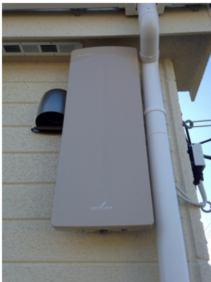
相模原市南区湘南 壁面取付 デザインアンテナ工事
