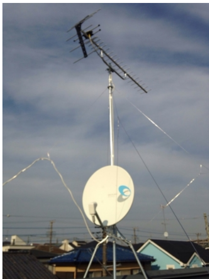
相模原市南区上鶴間 地デジアンテナとBSアンテナ屋根上工事
