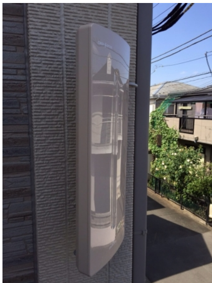
相模原市南区相南 美都住販様物件 壁面取付 デザインアンテナ工事
