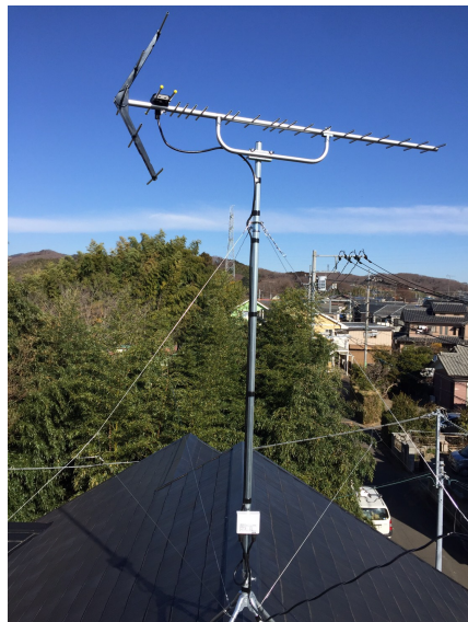
相模原市緑区川尻 屋根上設置 八木式アンテナ工事
