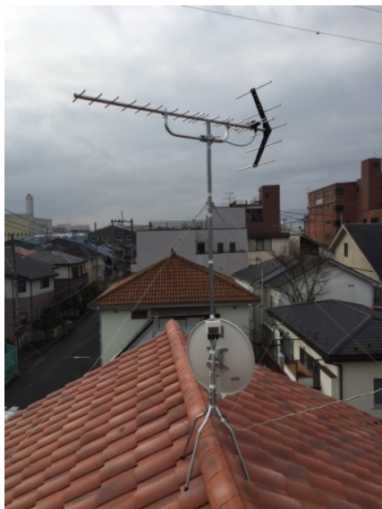
相模原市緑区西橋本 相陽建設様物件 地デジアンテナとBSアンテナ屋根上工事
