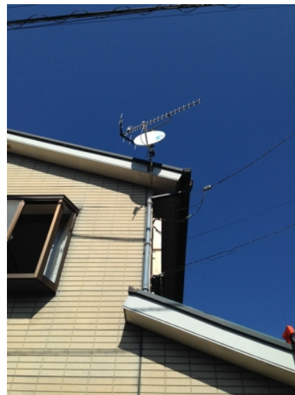
相模原市緑区岩井 内田工務店様物件 垂直偏波 受信 壁面取付 地デジアンテナとBSアンテナ工事
