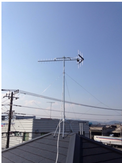
相模原市中央区上溝 垂直偏波受信 地デジアンテナ屋根上工事
