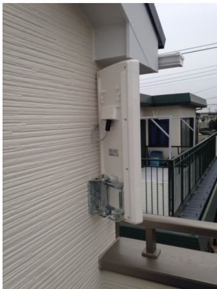
相模原市中央区光が丘 壁面取付 デザインアンテナ工事
