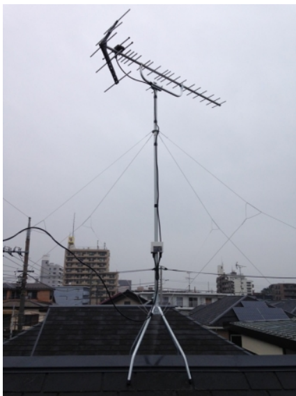
相模原市中央区星ヶ丘 地デジアンテナ屋根上工 事
