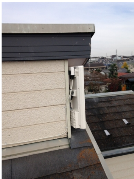
相模原市中央区宮下 壁面取付 デザインアンテナ工事
