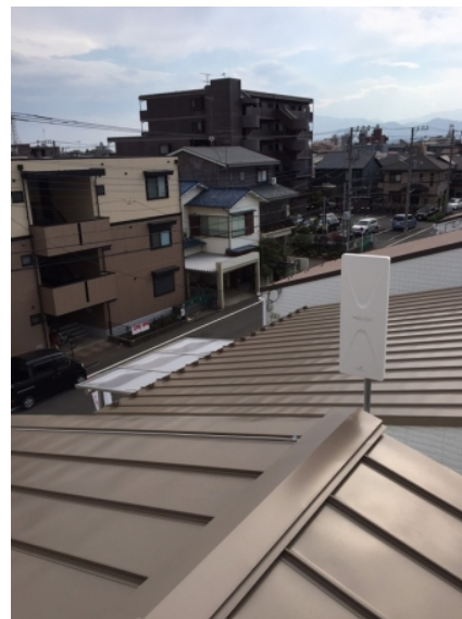
相模原市中央区千代田 壁面取付 デザインアンテナ工事
