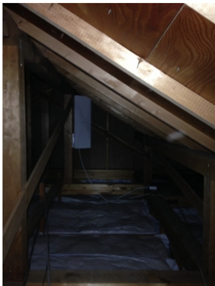
相模原市中央区清新 デザインアンテナ屋根裏工事
