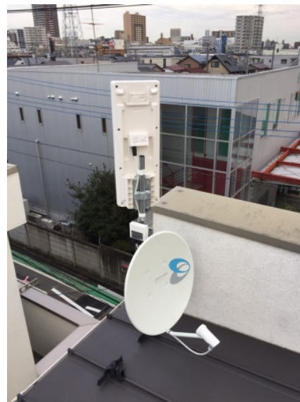
相模原市中央区清新 壁面取付 デザインアンテナとBSアンテナ工事
