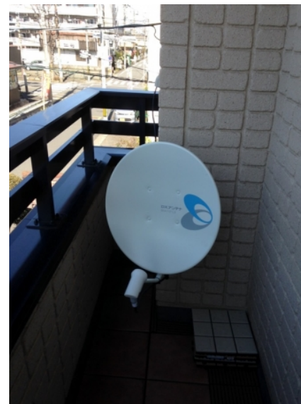
相模原市中央区横山 壁面取付 BSアンテナ工 事
