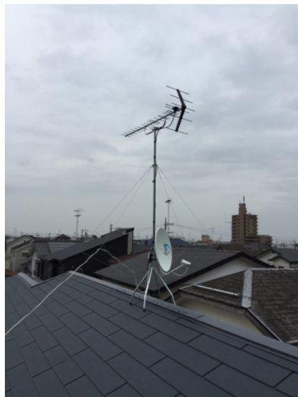
相模原市中央区星が丘 グリーンハウジング様物件 地デジアンテナとBSアンテナ屋根上工事
