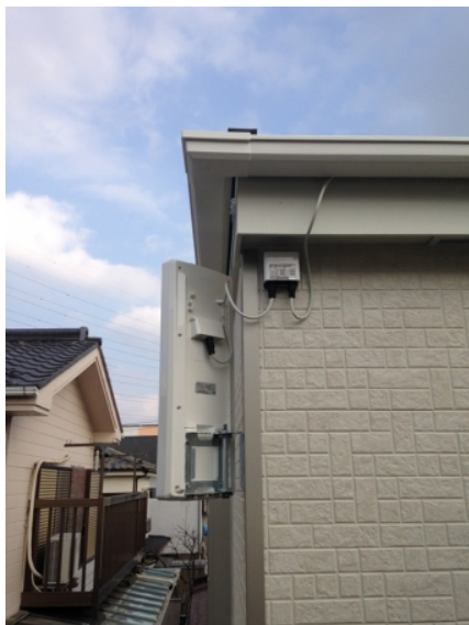
相模原市中央区小山 飯田産業様物件 壁面取付 デザインアンテナ工事
