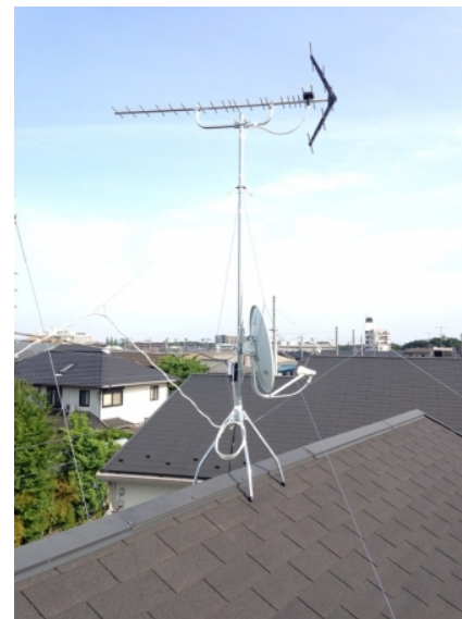
相模原市中央区横山台 アーネストワン様物件 地デジアンテナとBSアンテナ屋根上工事
