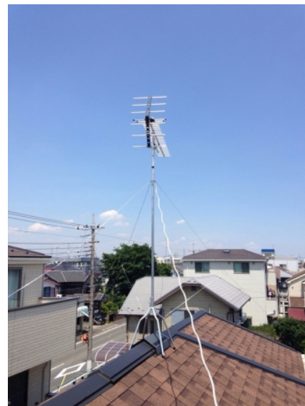
相模原市中央区千代田 サンケイホーム様物件 地デジアンテナ屋根上工事
