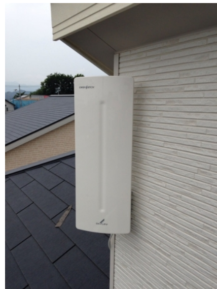
相模原市中央区下九沢 東栄住宅様物件 壁面取付 デザインアンテナ工事
