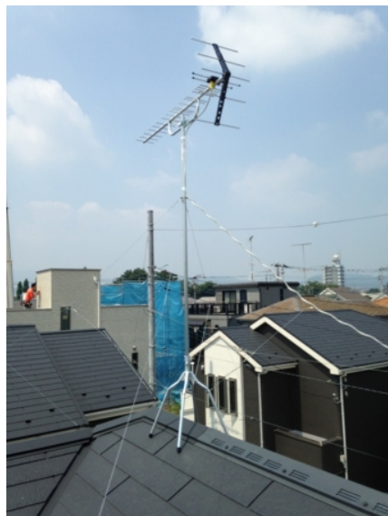
相模原市中央区上溝 城南建設様物件 地デジアンテナ屋根上工事
