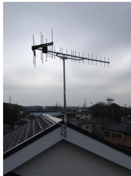
相模原市中央区上溝 アーネストワン様物件 垂直偏波受信 壁面取付 地デジアンテナ工事
