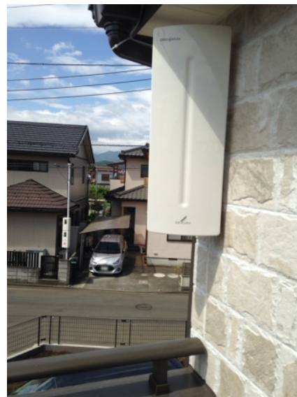
相模原市中央区田名 壁面取付 デザインアンテナ工事
