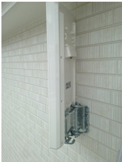
相模原市中央区宮下本町 一建設様物件 壁面取付 デザインアンテナ工事
