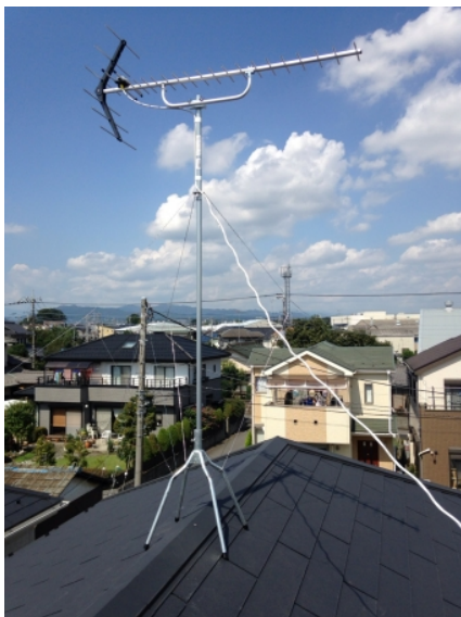
相模原市中央区上矢部 地デジアンテナ屋根上工事
