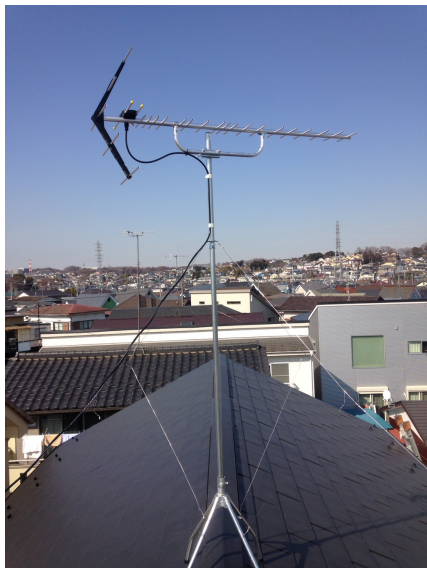
相模原市中央区 カキザワ工務店様ご物件 屋根上設置 八木式アンテナ工事
