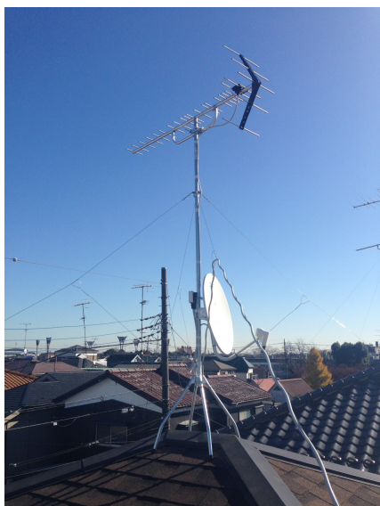
相模原市中央区並木 住宅情報館様ご物件 屋根上設置 八木式アンテナとBS/CSアンテナ工 事
