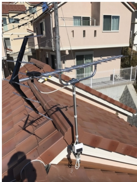
川崎市宮前区土橋 壁面取付 地デジアンテナ工事
